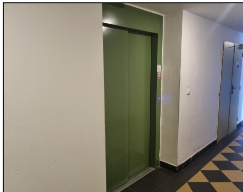
Obr.2 Šachetní dveře výtahu
