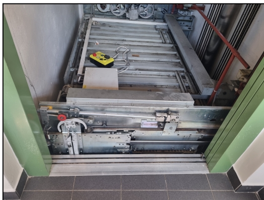
Obr.5 Pohled do šachty hydraulického výtahu
