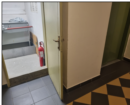
Obr.4 Vstup do strojovny
