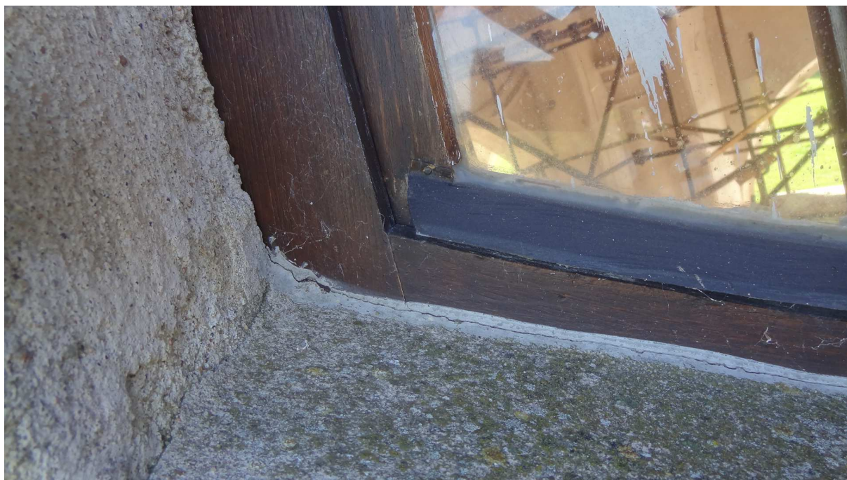
Detail okna se železnou okapnicí
