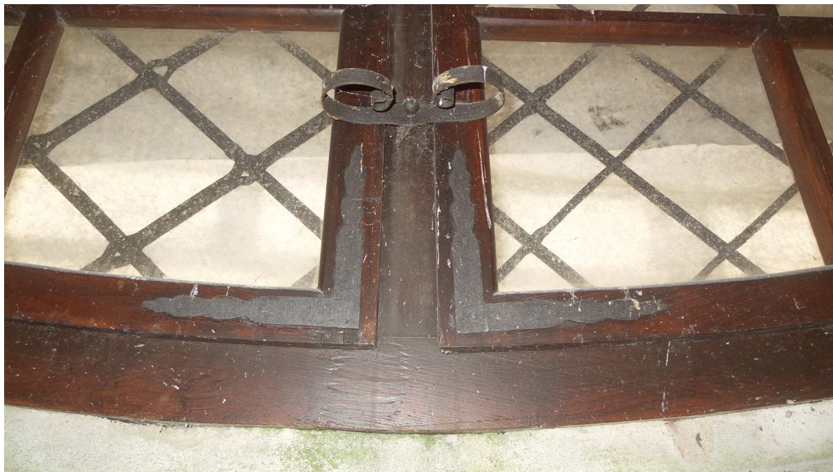
Rohovníkové kování z vnitřní strany
