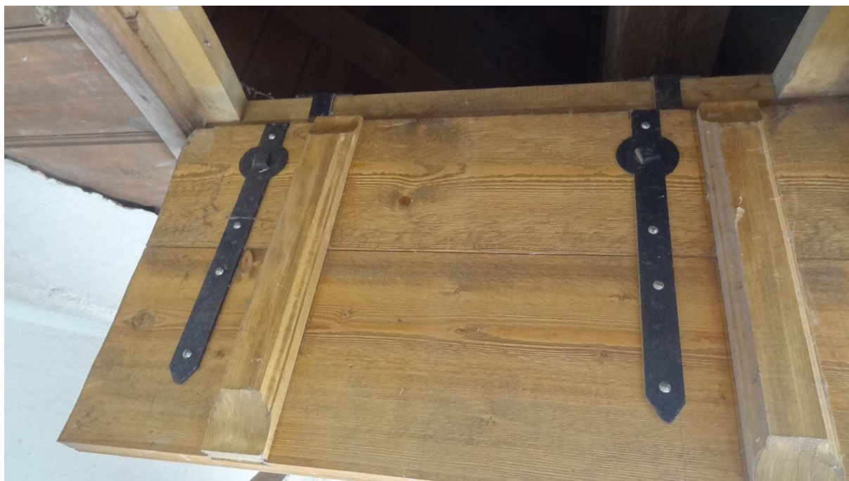
Kování dvířek z vnitřní strany od krovů
