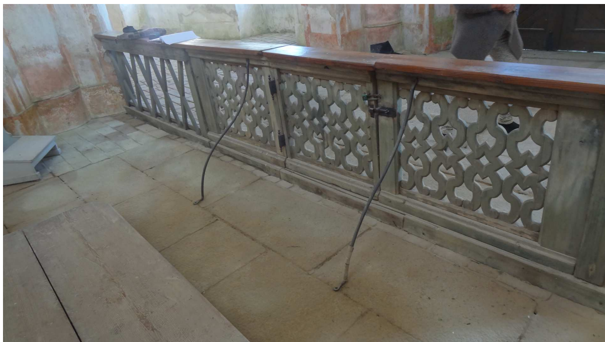
Pohled na mřížku z vnitřní strany
