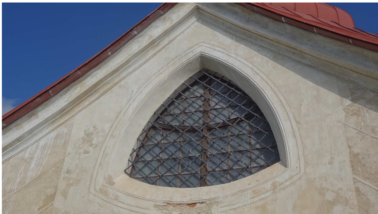
Okno s mříží z vnější strany
