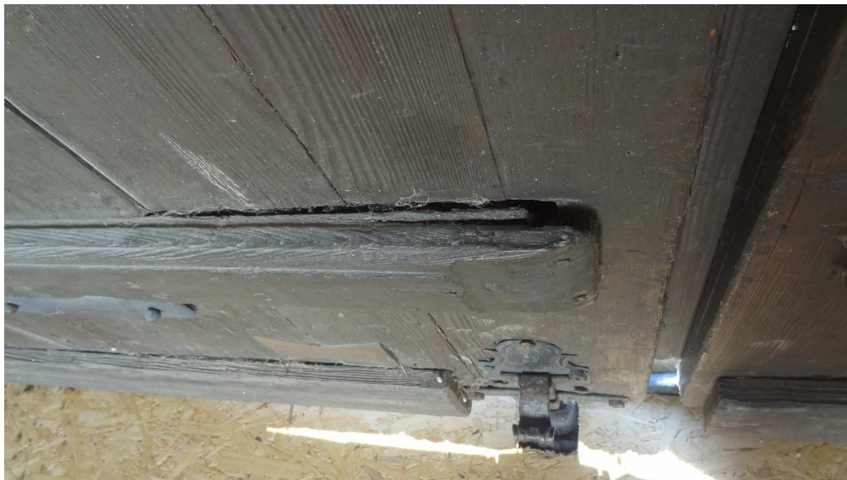
Detail uvolněných svlaků
