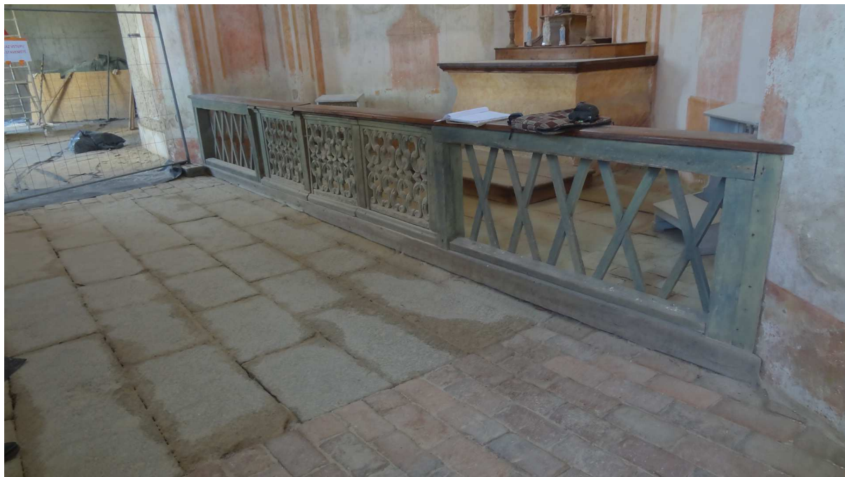
Celková pohled na mřížku z vnější strany
