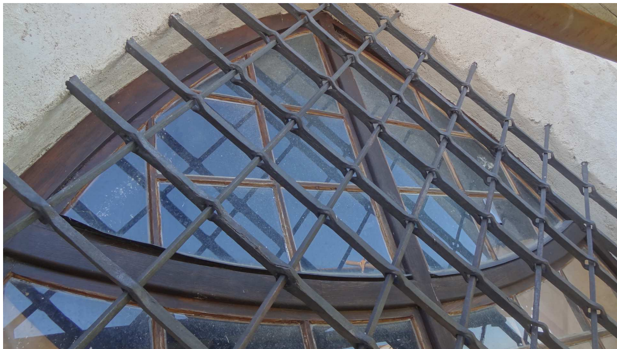
Detail kované mříže
