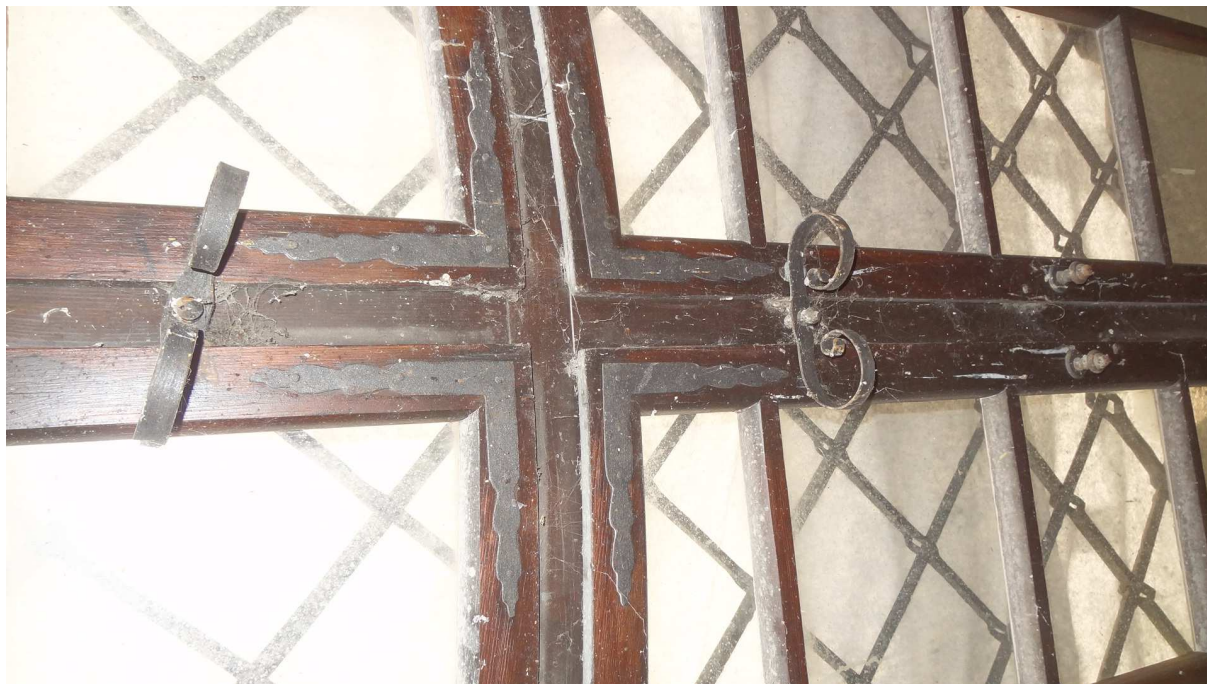
Rohovníkové kování z vnitřní strany
