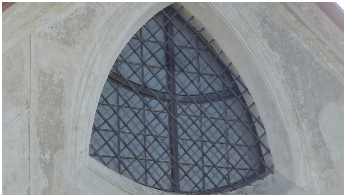
Degradované povrchové úpravy oken
