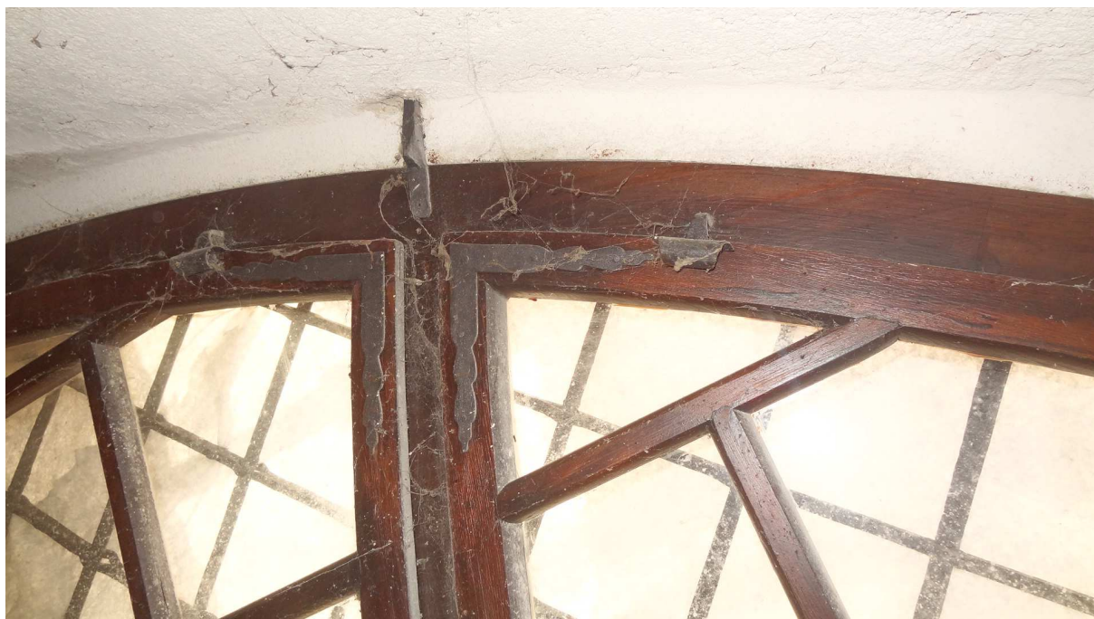
Rohovníkové kování z vnitřní strany
