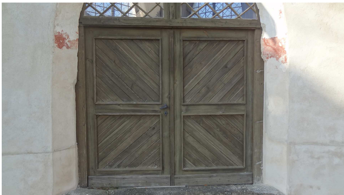
Na vratech je patrné svěšení uvolněné konstrukce
