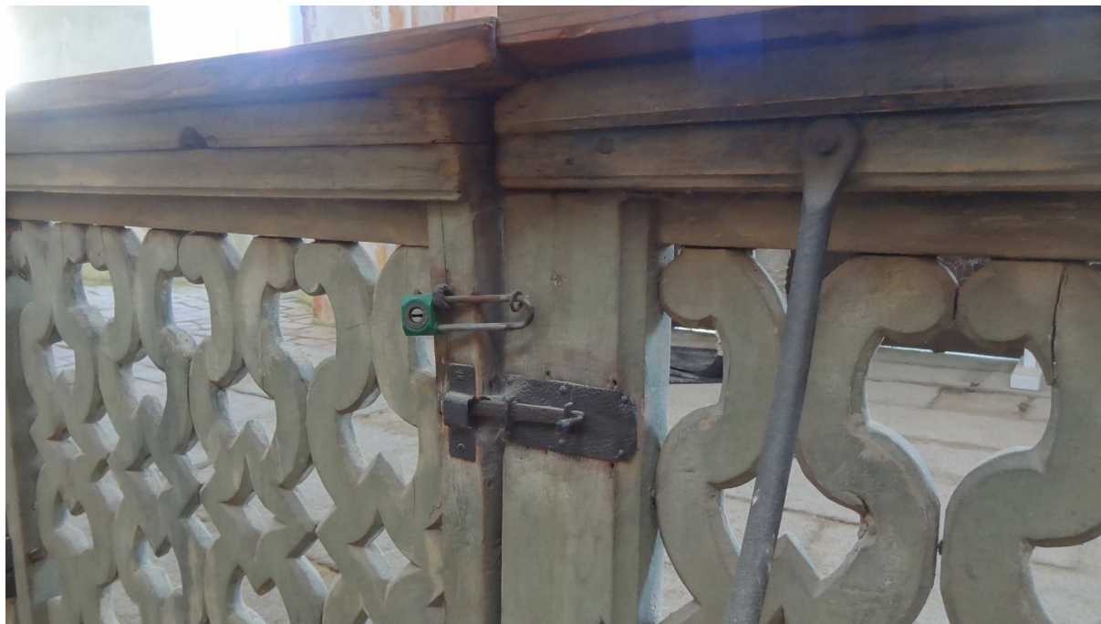
Detail původního kování dvířek mřížky
