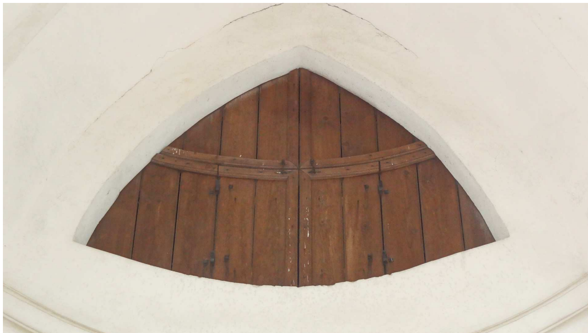
Dvířka do prostoru krovu ambitů - s profilovým dělením
