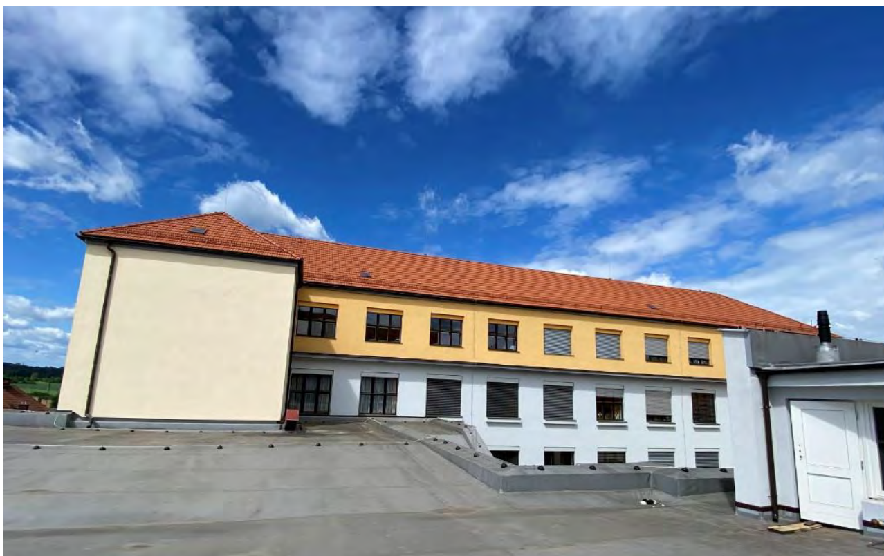
Obr: Střecha objektu č. 2
