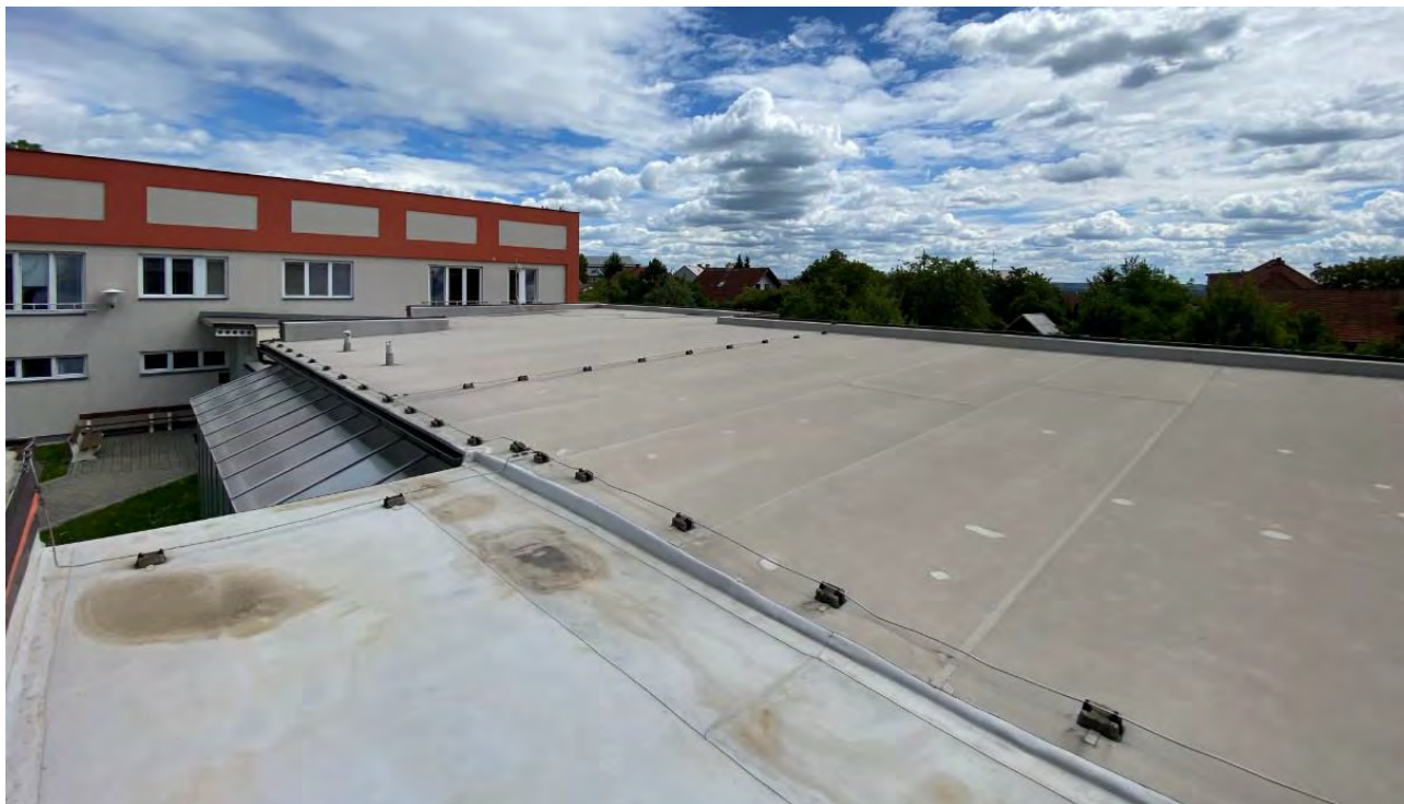
Obr: Střecha objektu č. 1
