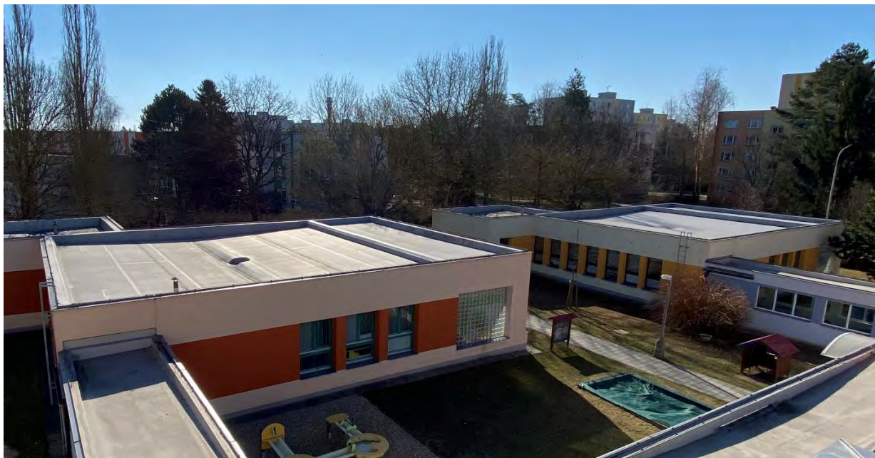
Obr: střechy obj. 3a a 3b
