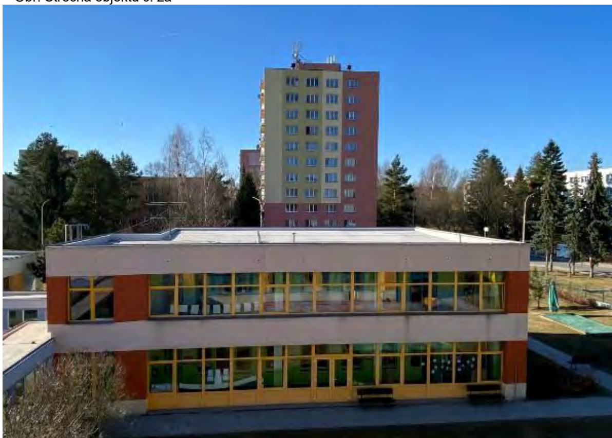
Obr: střecha obj. 2b
