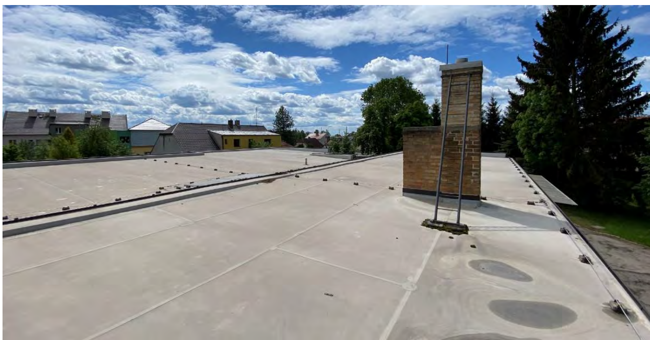
Obr: střecha objektu č. 2
