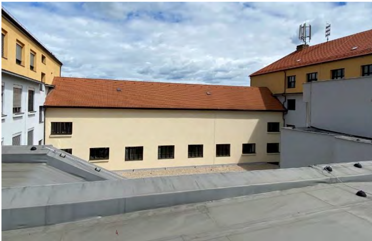
Obr: Střecha objektu č. 4
