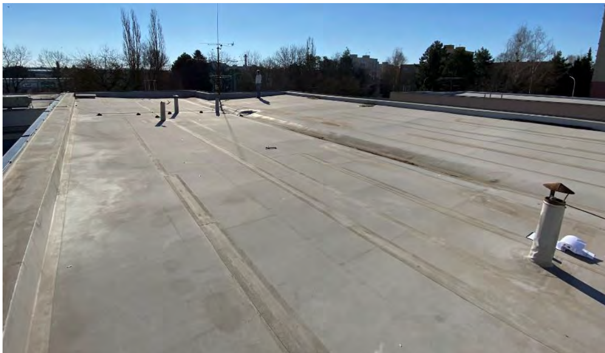
Obr: Střecha objektu č. 2a
