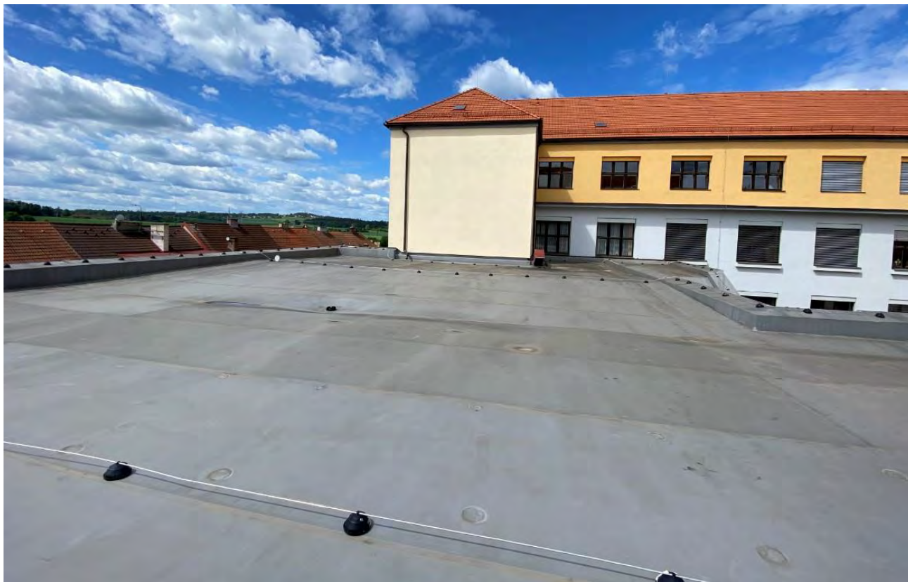
Obr: Střecha objektu č. 1
