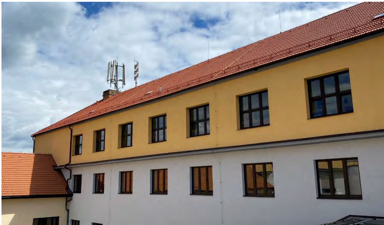
Obr: Střecha objektu č. 3
