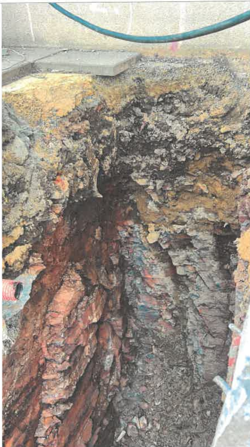
Pohled na sondu u jihovýchodní -ho průčelí
