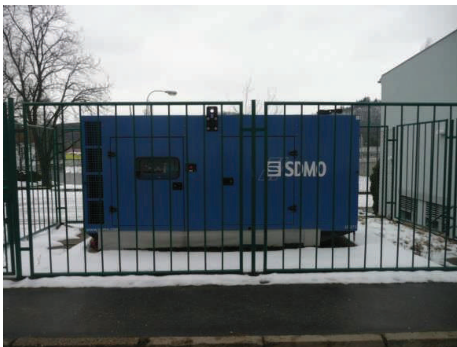
Obrázek 12: Diesel generátor
