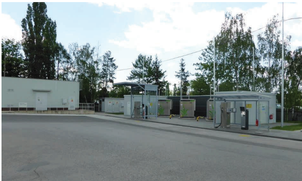
Obrázek 11: Čerpací stanice CNG
