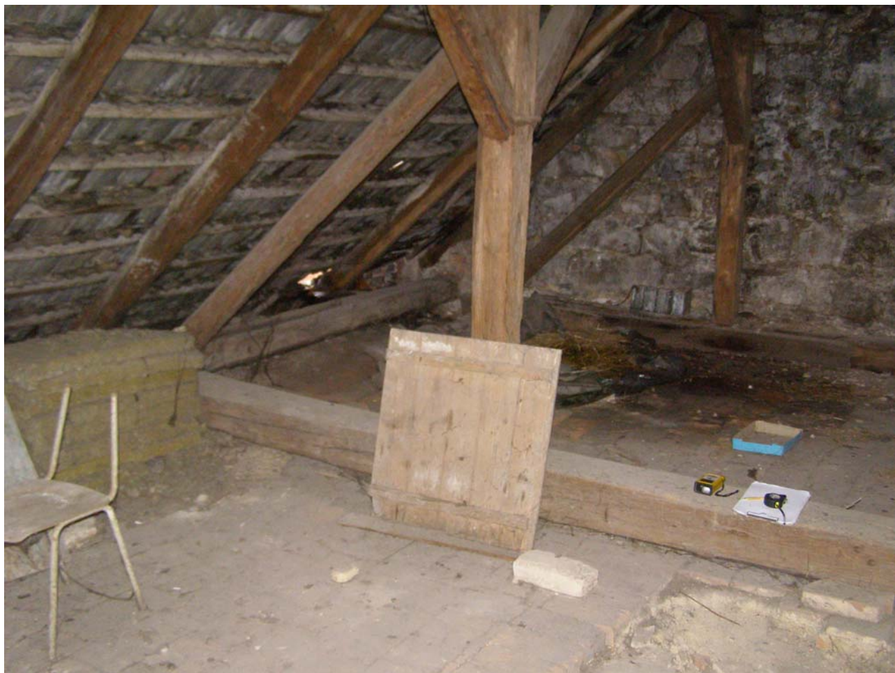
7. KROV - JIŽNÍ STRANA
