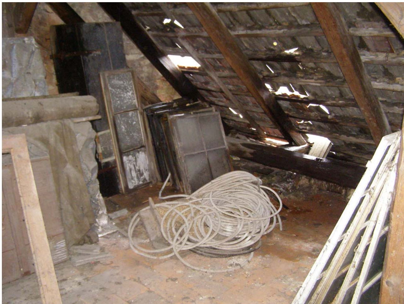
5. KROV - JIŽNÍ STRANA
