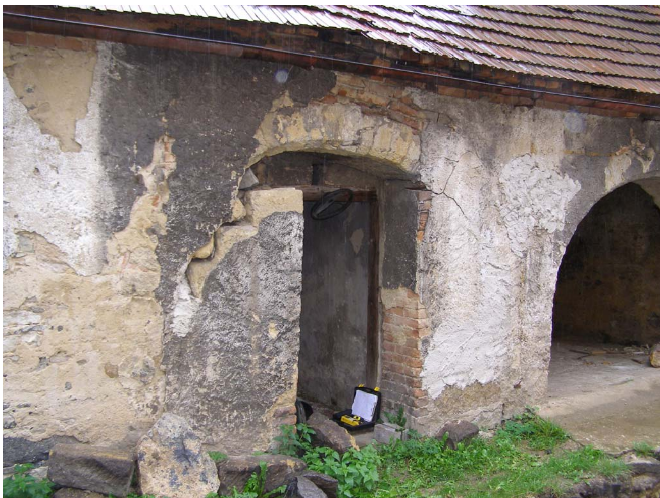
2. SEVERNÍ PRŮČELÍ - ZAZDĚNÁ ARKÁDA
