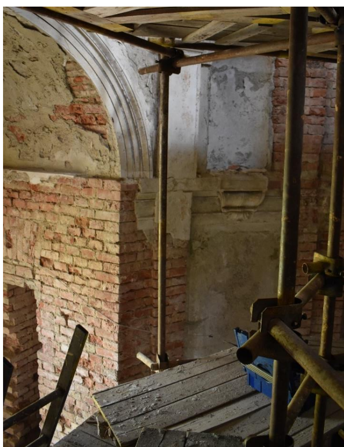
Pohled na spodní partie u vstupu, kde omítky zcela chybí. Fragment mramoru na pilastru.
