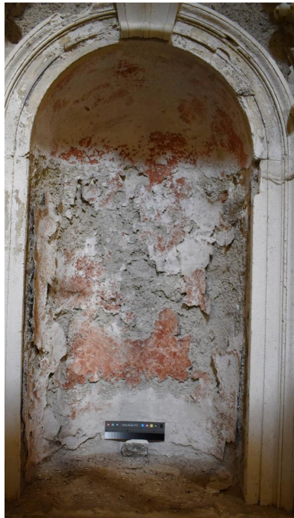
Severozápadní strana s nikou se zbytky barevnosti pravděpodobně červeného mramorování. Detail zbytku řešení akantu hlavice a štukového archivoly niky s tmavou linkou ve stínu.
