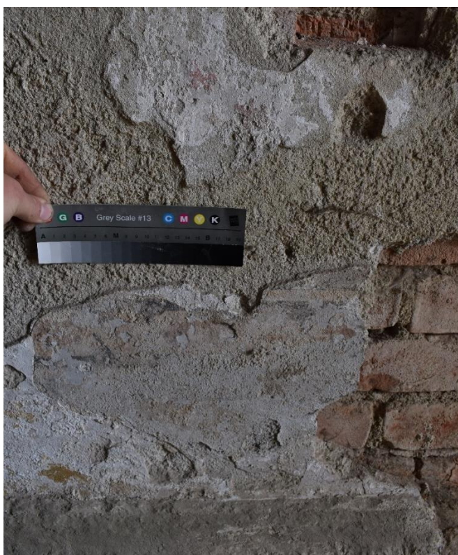
Detail zbytků omítky na západní stěně při vstupu (spodní partie výšky asi 50 cm). Pohled na východní kapli.
