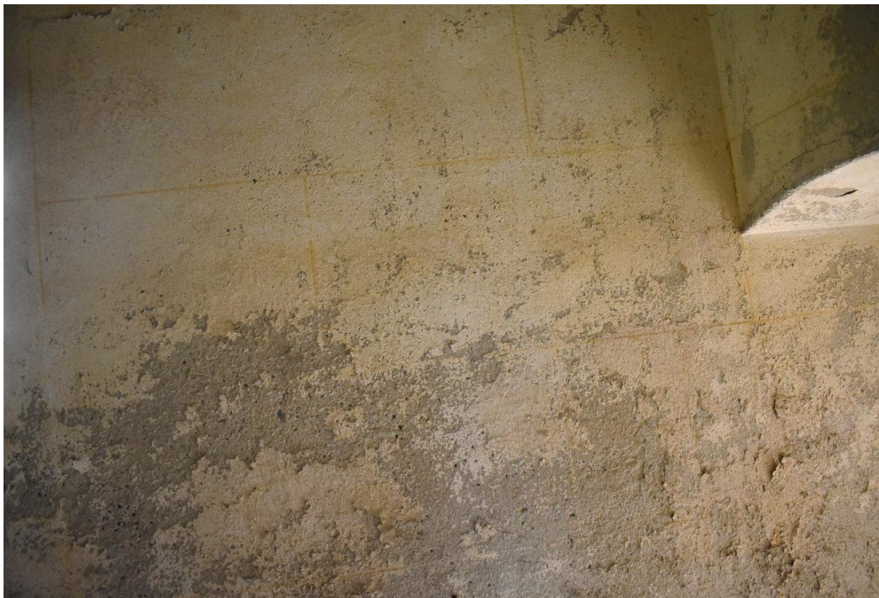
Severozápadní rohová místnost s kvádříkováním na stěnách.
