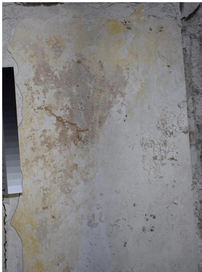
Pohled na spodní partie u vstupu, kde omítky zcela chybí. Fragment mramoru na pilastru.
