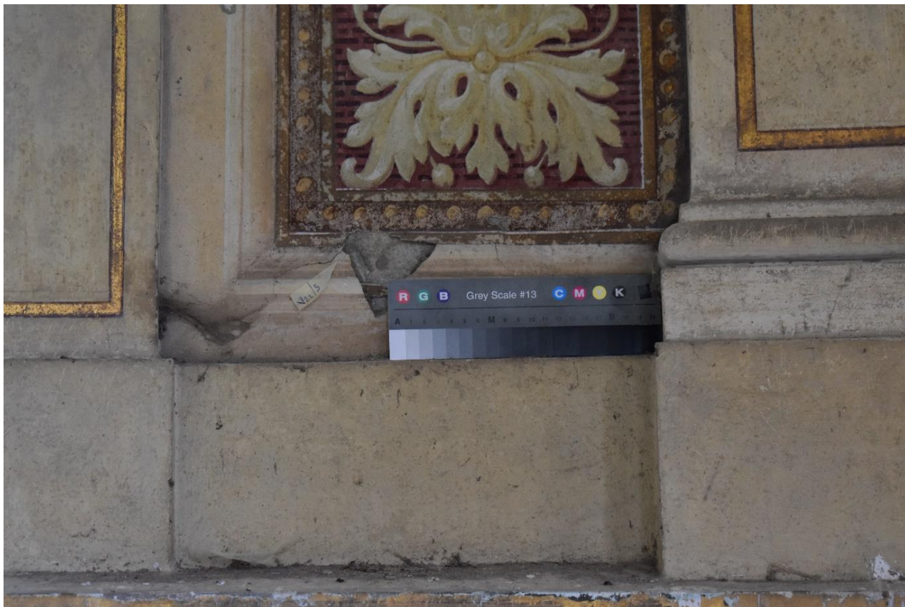
Detail odběru místa vzorku na severozápadní straně spodní soklová část pilastru.
