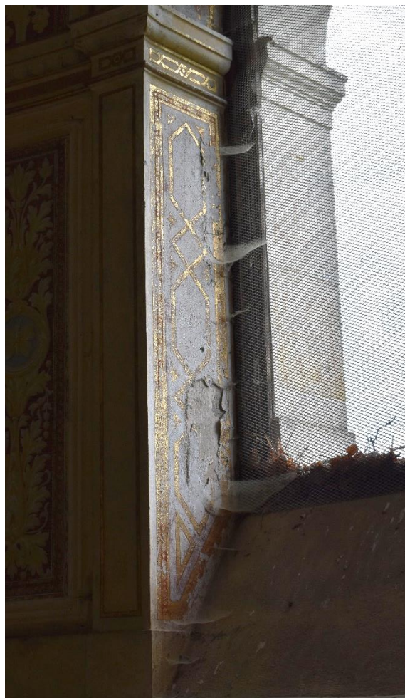
Stav maleb na severní straně kopule s detailem (malby byly barevnějšího projevu, nyní v dochovaných částech patrné jen obrysy motivů s podmalbami – nasčítaných vrstev, kde se pojivo ještě zcela není zdegradované. Dále detail okenní špalety se zlacenými detaily (typické poškození pro většinu oken se zlacenými dekory).
