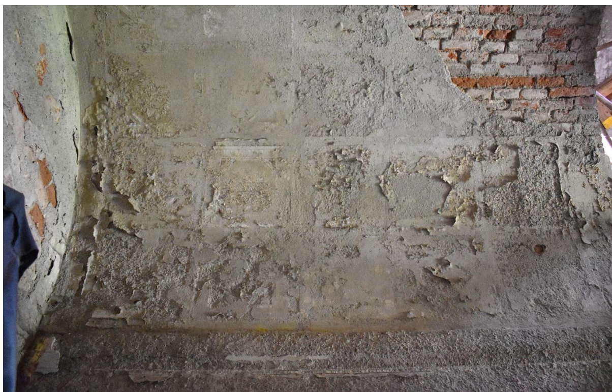
Pohled do jižní kaple. Zbytky obrysů kazetování.
