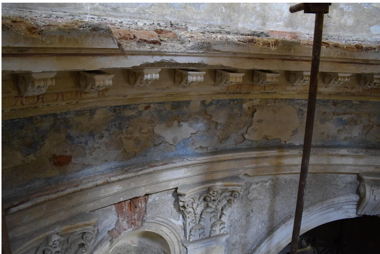
Západojižní část stěn.
