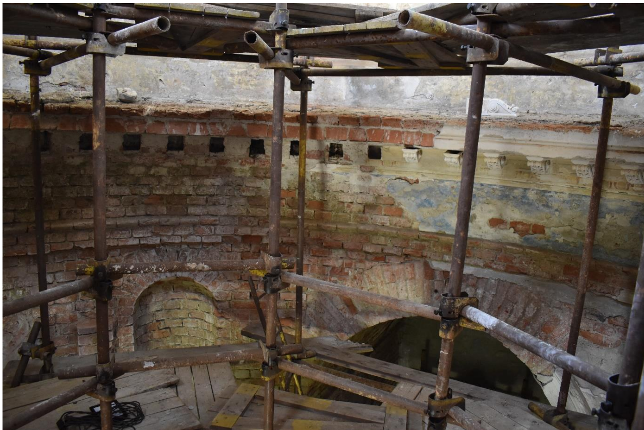
Pohled na nejspodnější část stěn nad kaplemi jihovýchod.
