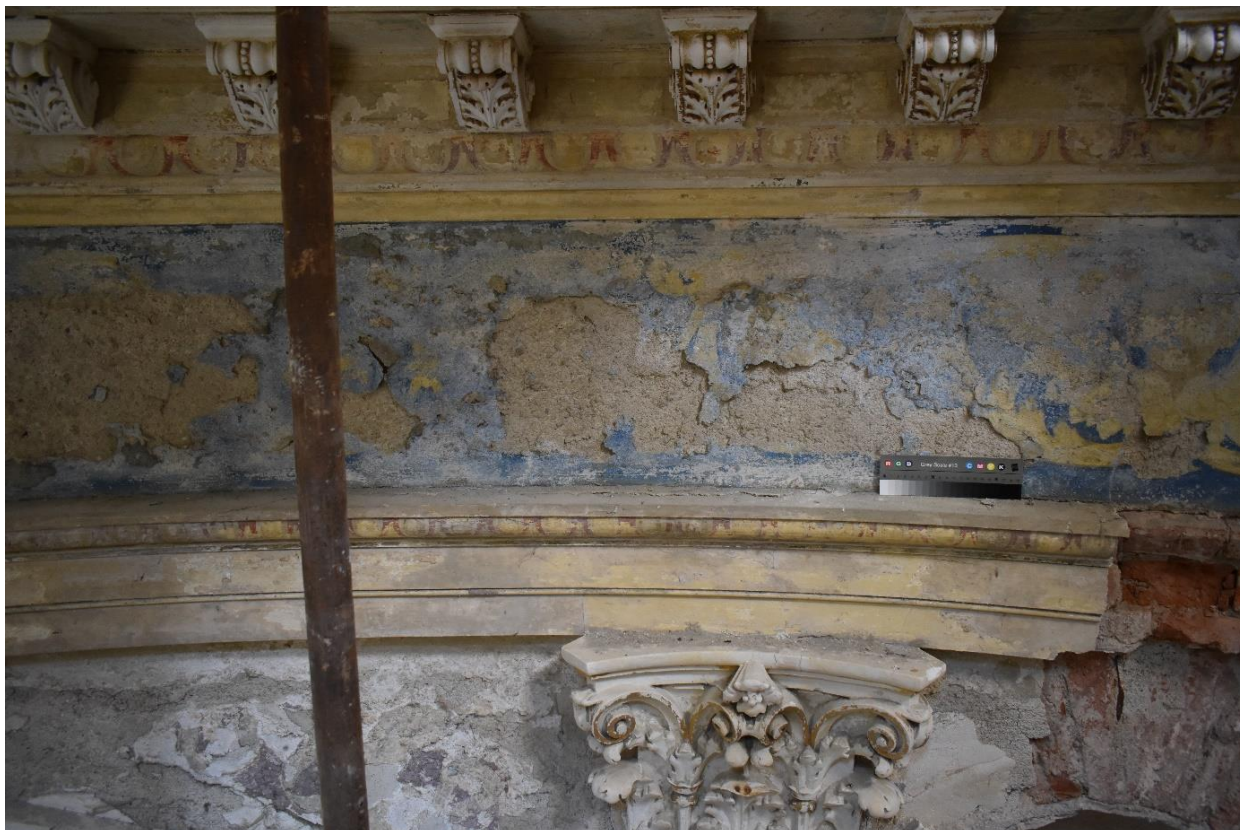
Stav omítek ve spodních částech kopule – vlys na severní straně. Kde jsou malby málo dochované, motivy špatně čitelné. Tudíž nelze jednoznačně dotvořit- rekonstruovat případnou výmalbu.
