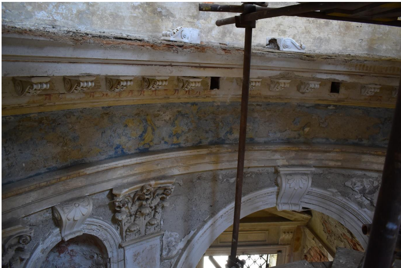
Pohled na stěny nad vstupem (sever).
