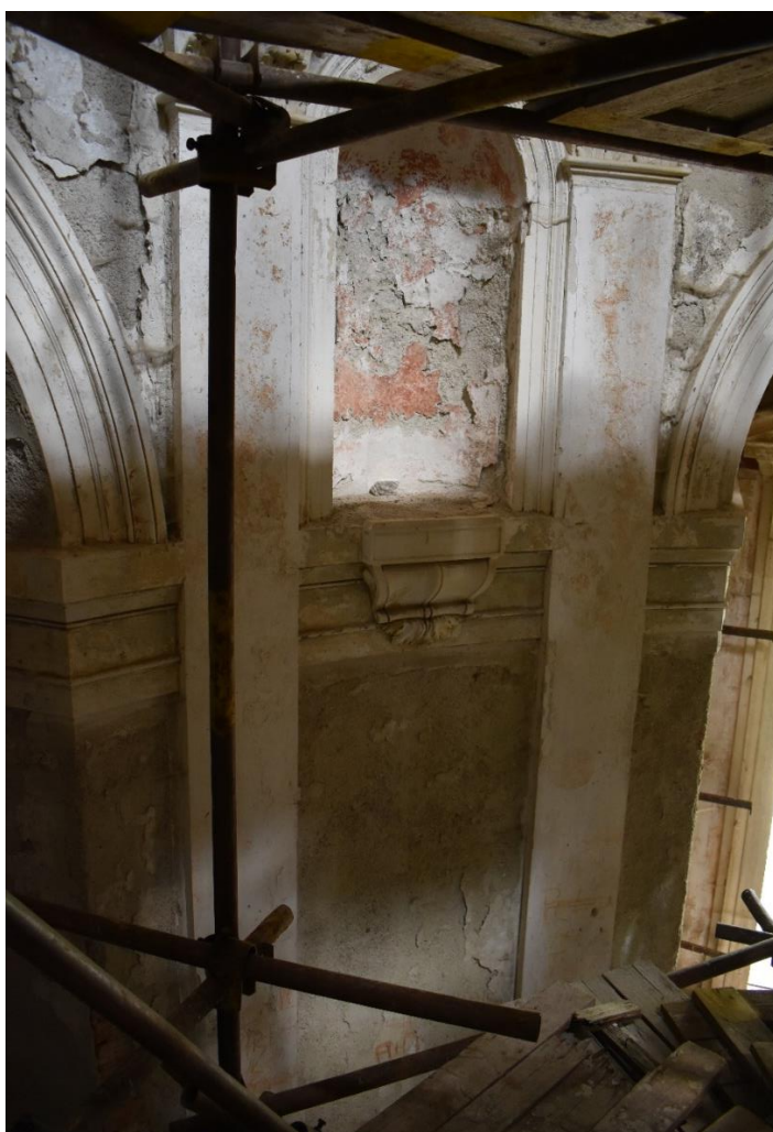
Severozápadní strana s nikou se zbytky barevnosti pravděpodobně červeného mramorování. Detail zbytku řešení akantu hlavice a štukového archivoly niky s tmavou linkou ve stínu.
