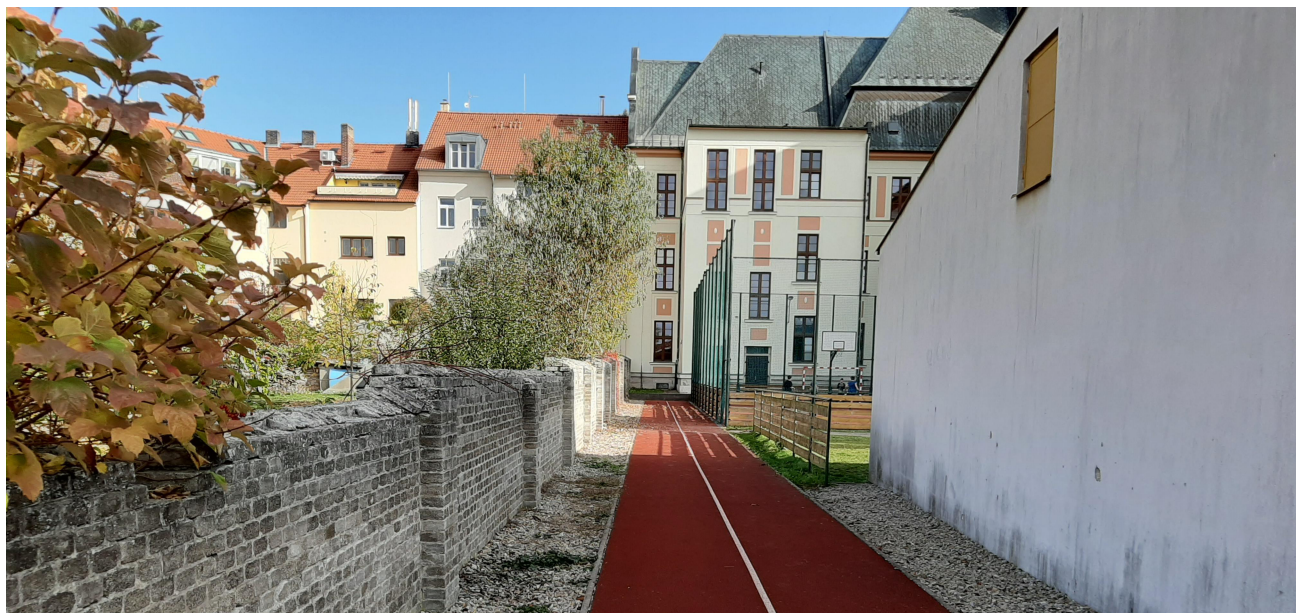
ŠTÍT STÁVAJÍCÍHO PAVILONU, BĚŽECKÁ DRÁHA S UMĚLÝM POVRCHEM
