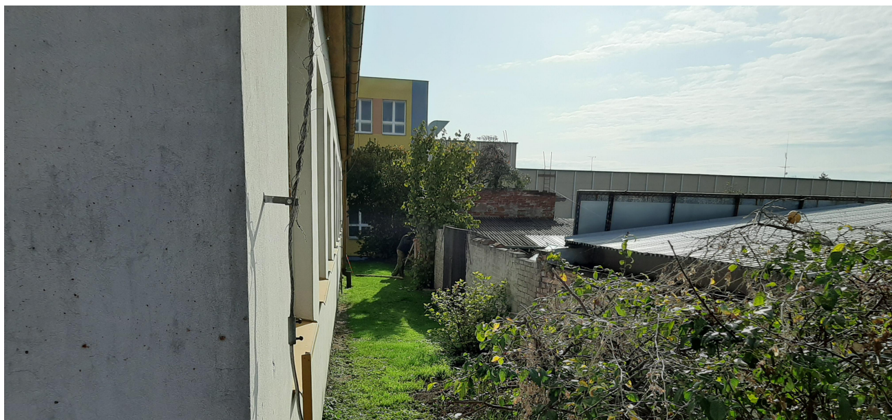
STÁVAJÍCÍ PAVILON, ZADNÍ ČÁST, OPĚRNÁ ZÍDKA, SOUKROMÉ POZEMKY
