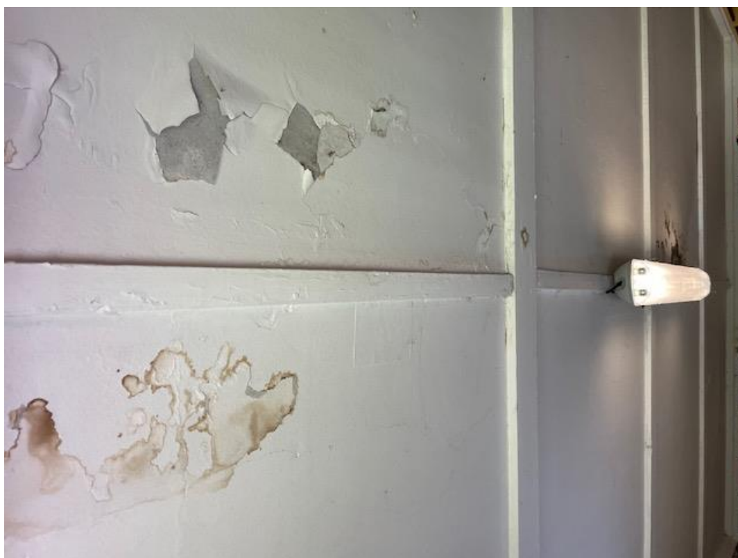
Stávající podhled budovy srubu
