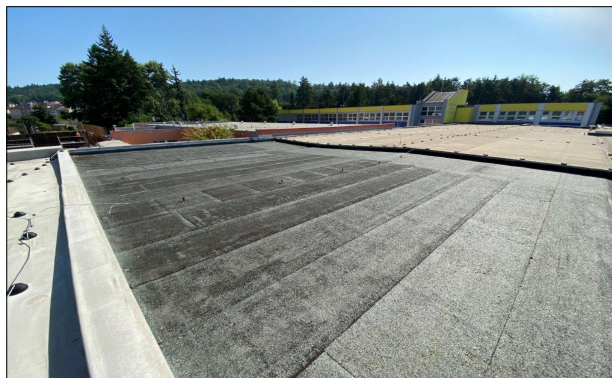
Foto /12/ Pohled na předmětnou střechu B.
