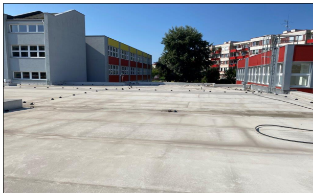
Foto /2/ Pohled na předmětnou střechu A.
