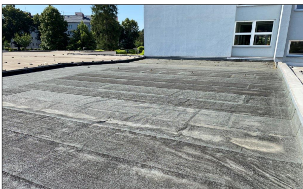
Foto /13/ Pohled na předmětnou střechu B.
