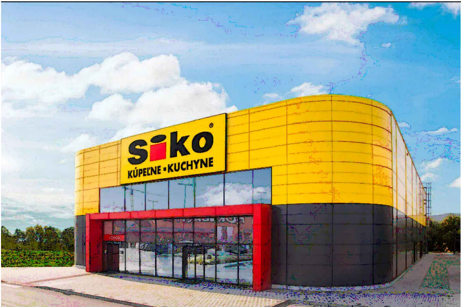
fasáda Ruukki - Sendvičový panel SP2D WE Energy tl. 200 mm RAL 7016 - tmavě šedá
