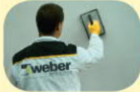
Po zaschnutí 2–3 dny, provedeme konečnou omítkovou vrstvu v tl. 2 mm.
