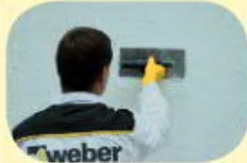
Po zaschnutí 2–3 dny, provedeme konečnou omítkovou vrstvu v tl. 2 mm.
