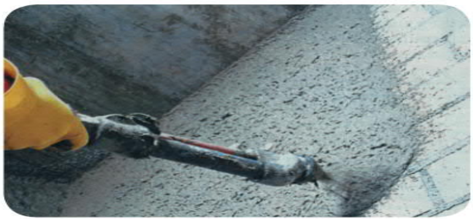
Po zaschnutí 2–3 dny, provedeme konečnou omítkovou vrstvu v tl. 2 mm.
