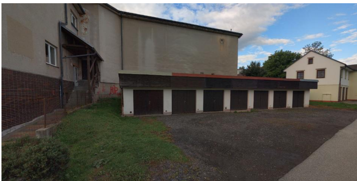
Pohled na zadní prostor objektu:
