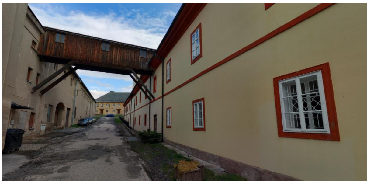
Pohled ulicí směrem k čp. 69:
