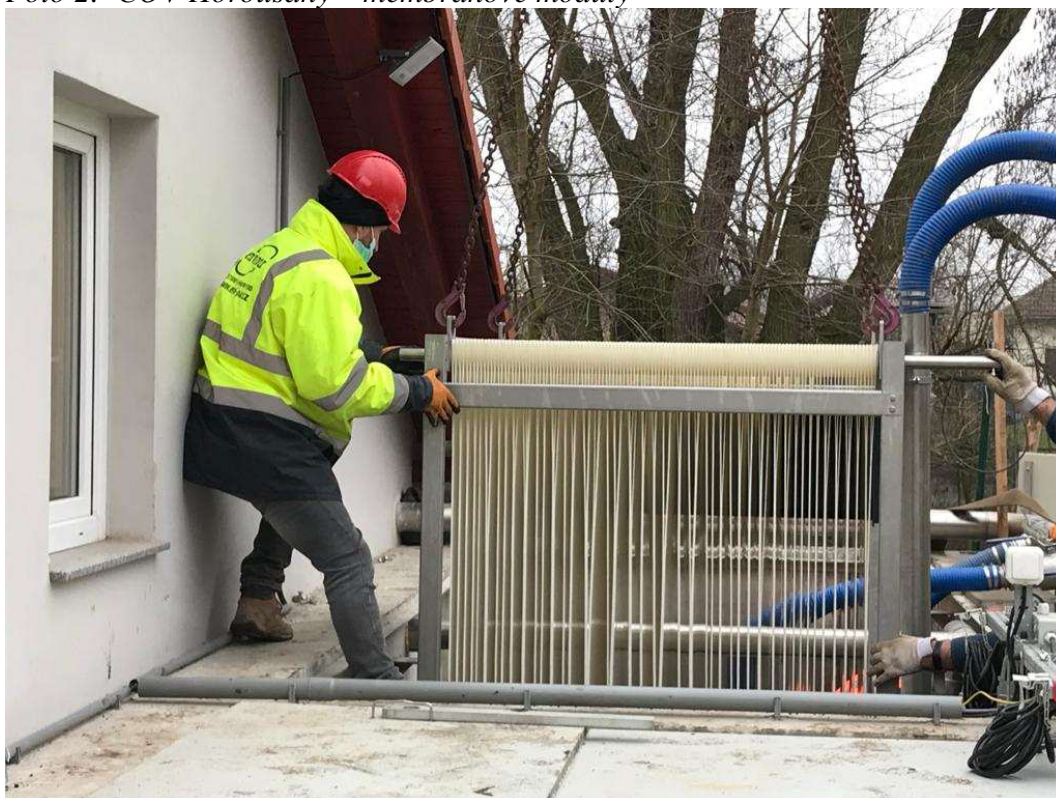
Foto 2: ČOV Horoušany – membránové moduly
