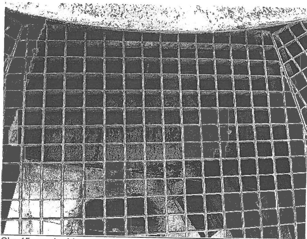
Obr. 15 – ocelová koruna víka VN1
