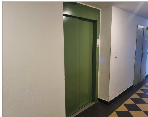
Obr.2 Šachetní dveře výtahu
