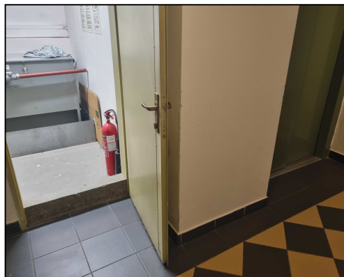
Obr.4 Vstup do strojovny
