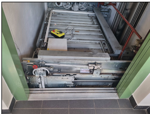
Obr.5 Pohled do šachty hydraulického výtahu
