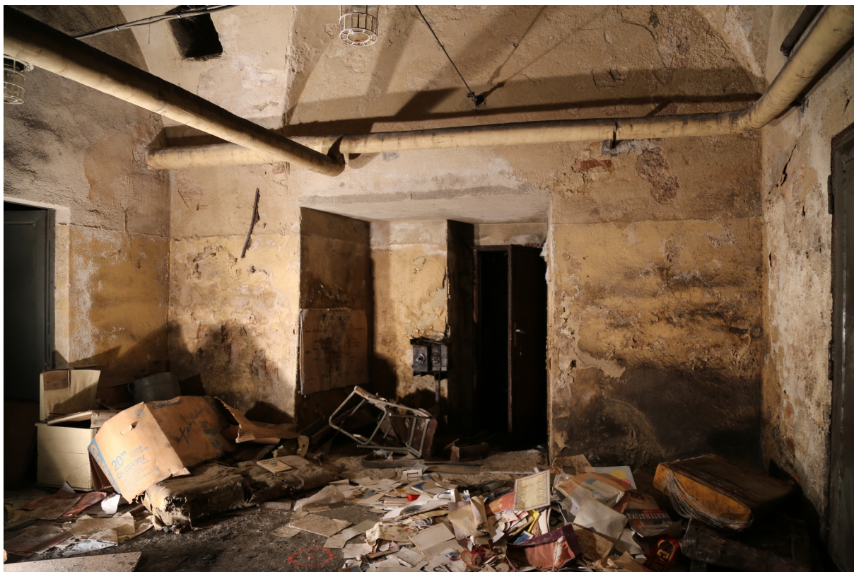
I.č. 03530-2017 Znojmo, někdejší klášter v Louce. Západní křídlo středověké kvadratury - Stará škola. Suterén, místnost 0.04 - pohled na západní stěnu.
