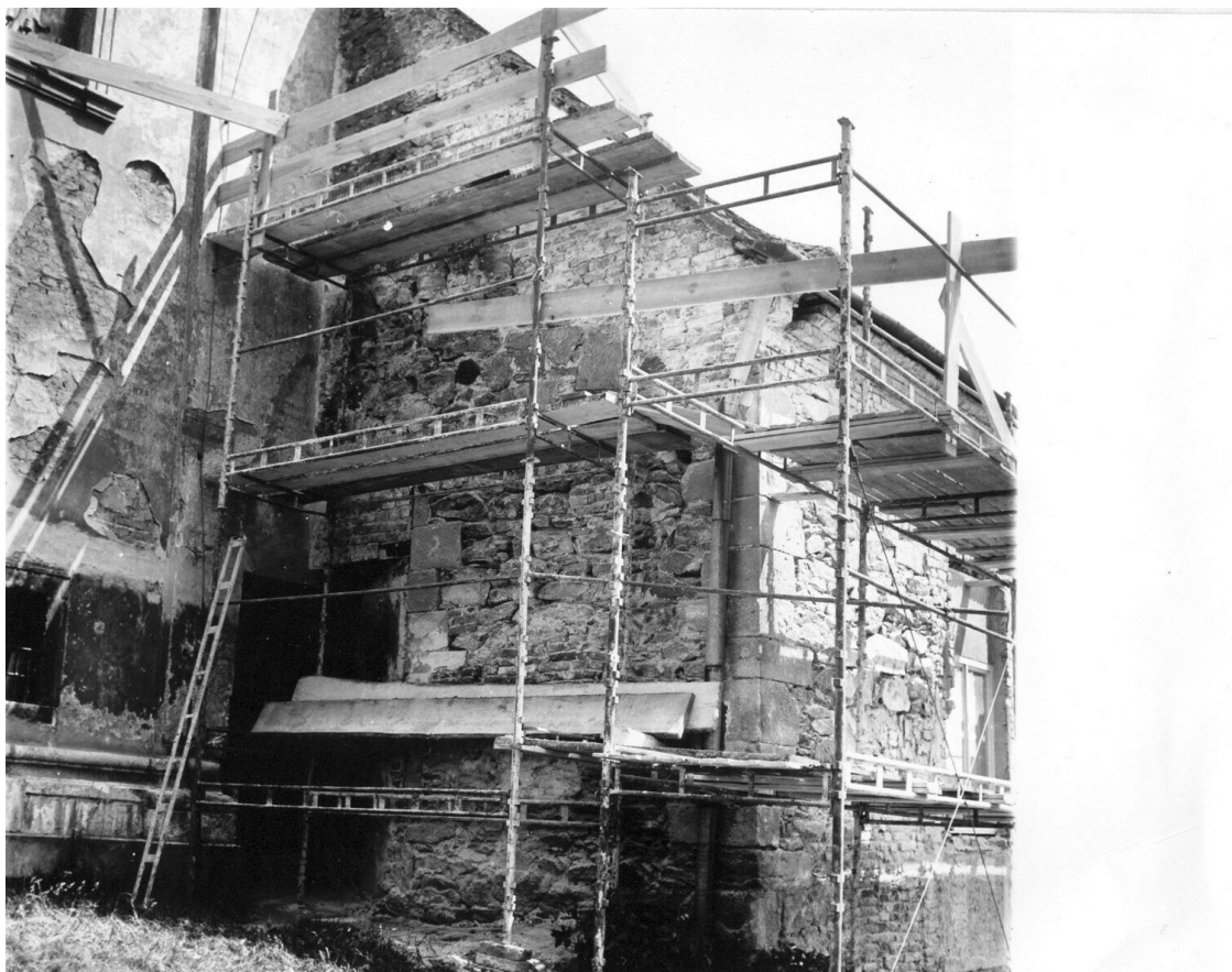
Foto při rekonstrukci fasády z 5. června 1972 (archiv Odboru výstavby MuZ).
