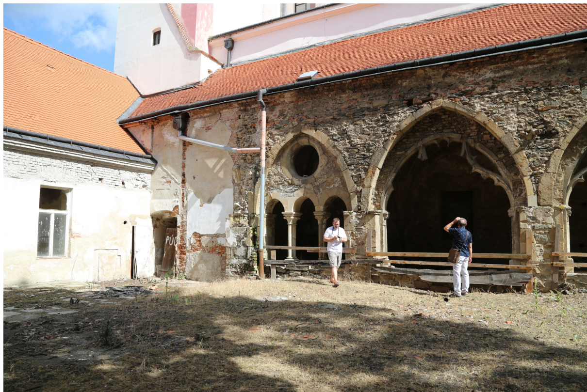
I.č. 03358-2017 Znojmo, někdejší klášter v Louce. Severní rameno ambitu.
