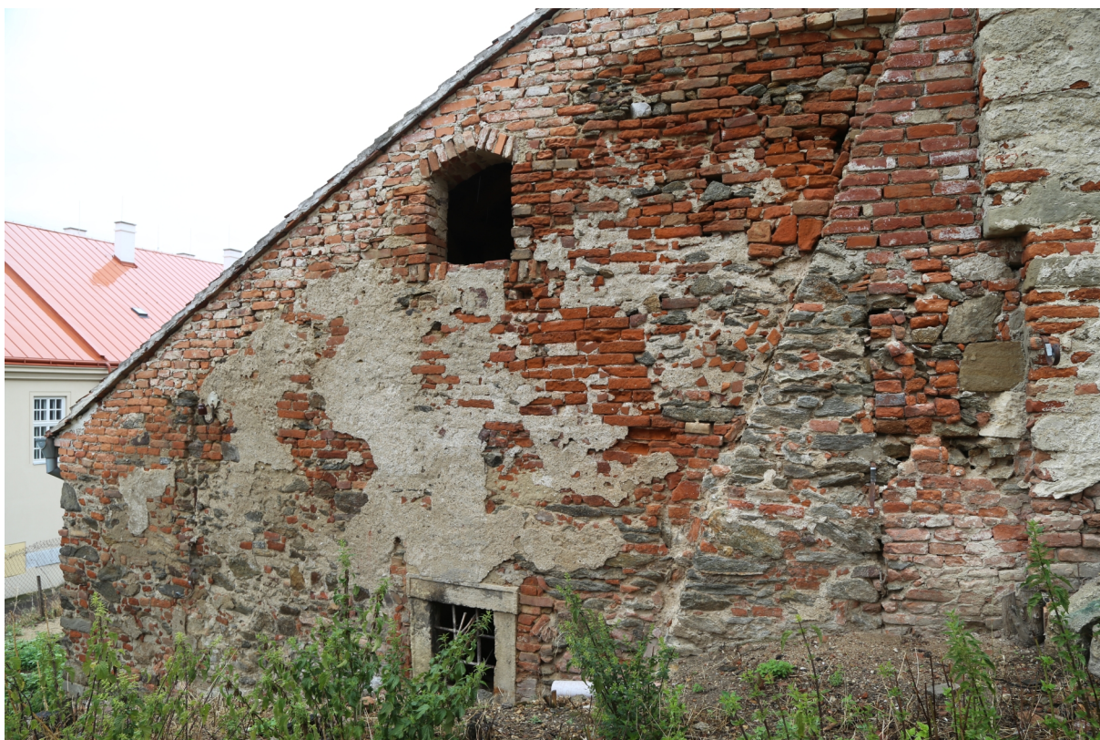
I.č. 03561-2017 Znojmo, klášter Louka - Stará škola. Západní křídlo někdejší středověké kvadratury. Pohled od východu na opěrný pilíř se zazděnou ubourávkou ohradní zdi kláštera.
