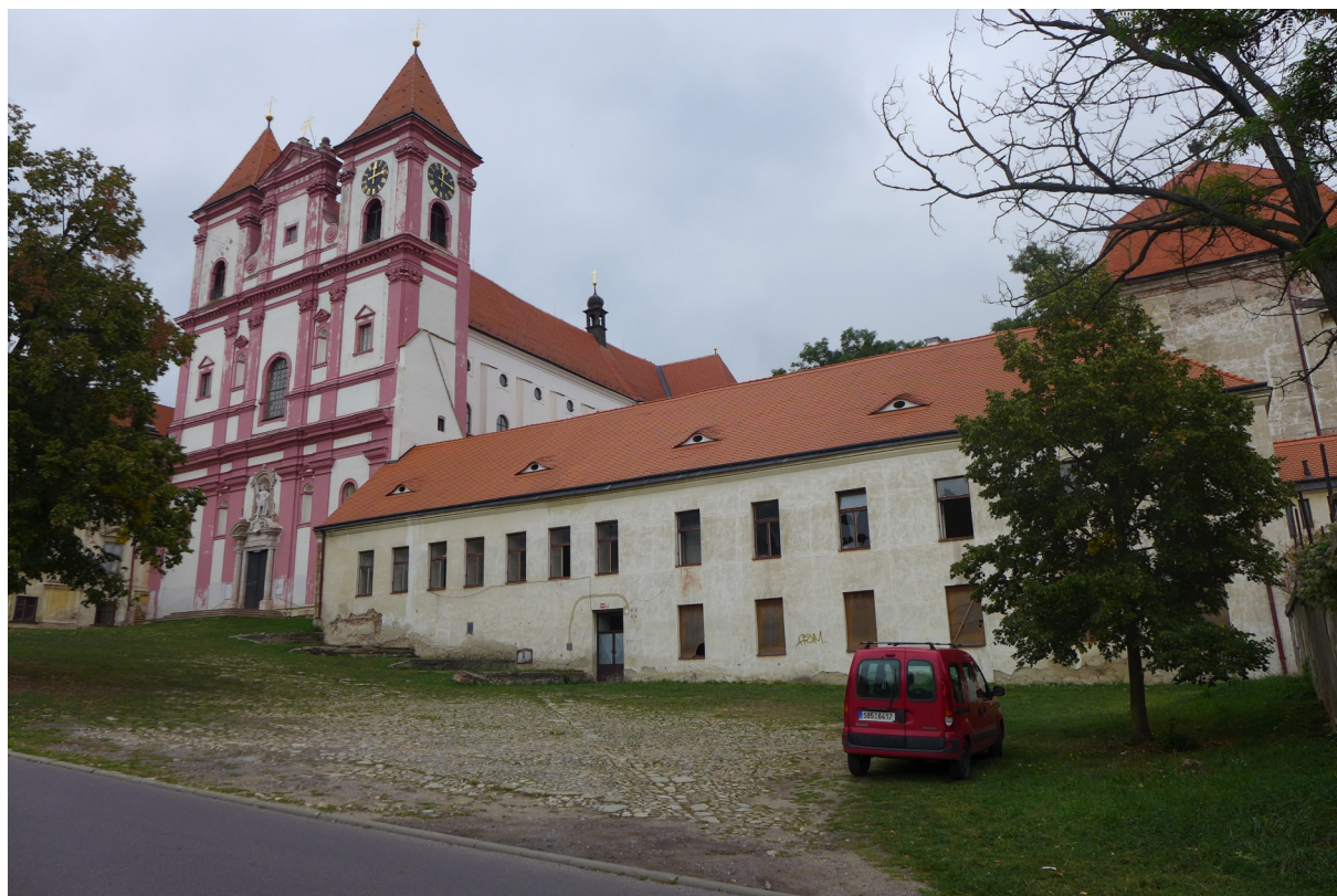
I.č. 04378-2017 Znojmo, klášter Louka - Stará škola, pohled od jihozápadu.
