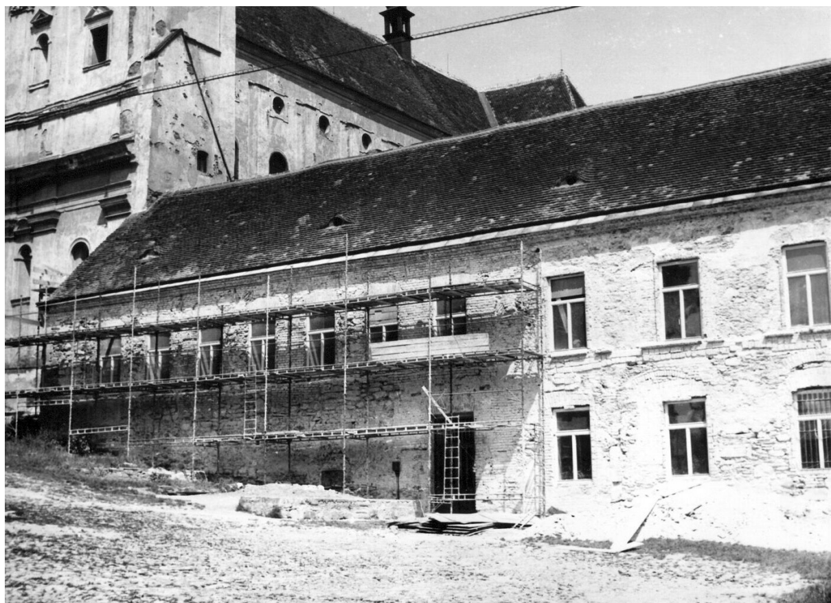
Foto při rekonstrukci fasády z 5. června 1972 (archiv Odboru výstavby MuZ).
