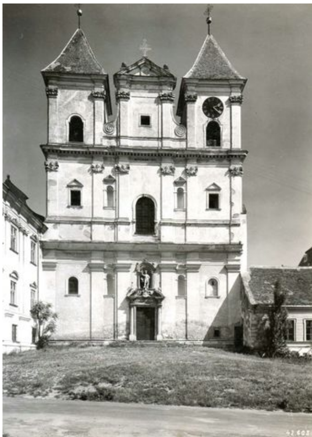
Průčelí kostela v meziválečném období (i.č. D2242 archiv JMZ).
