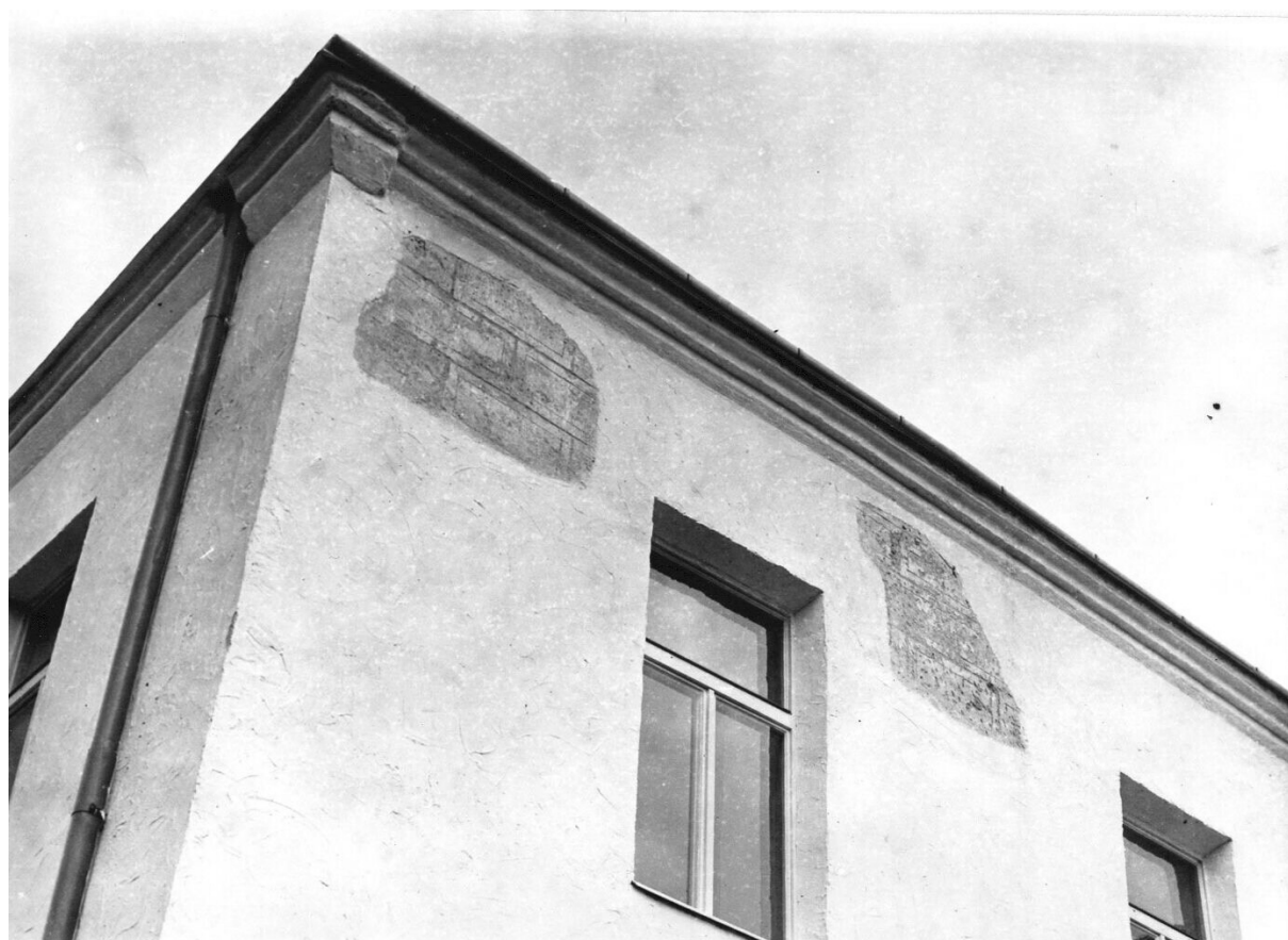
Foto při rekonstrukci fasády z roku 1972 (archiv Odboru výstavby MuZ).
