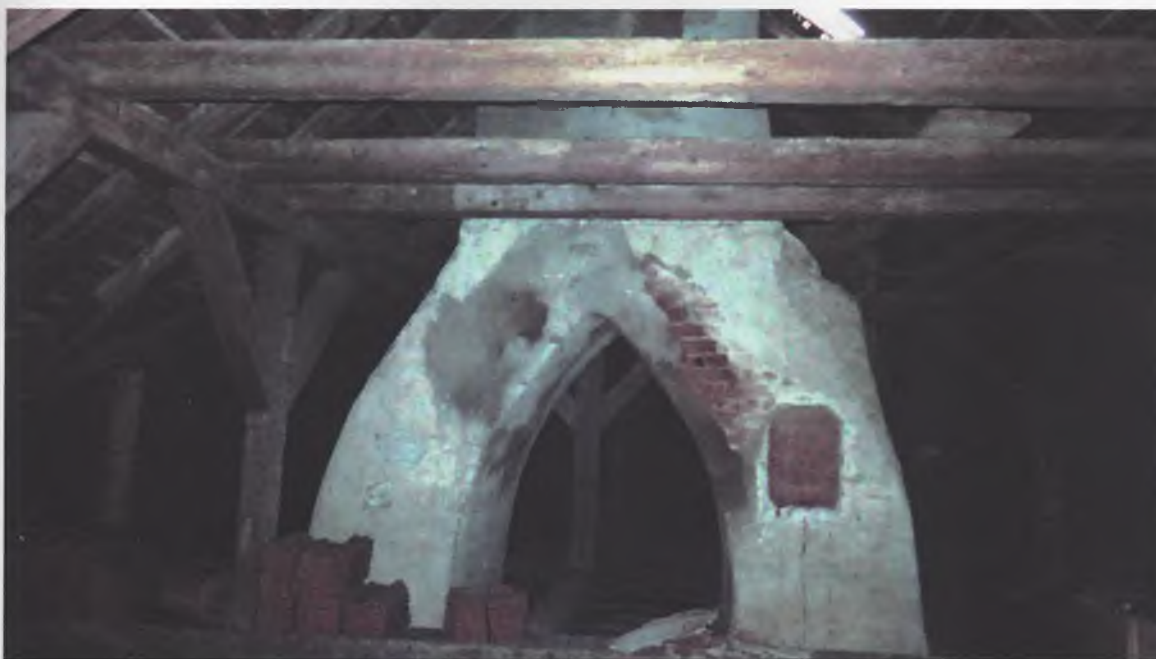
FOTO KOMÍNOVÉHO TĚLESA č.2 01/2018 stávající stav
