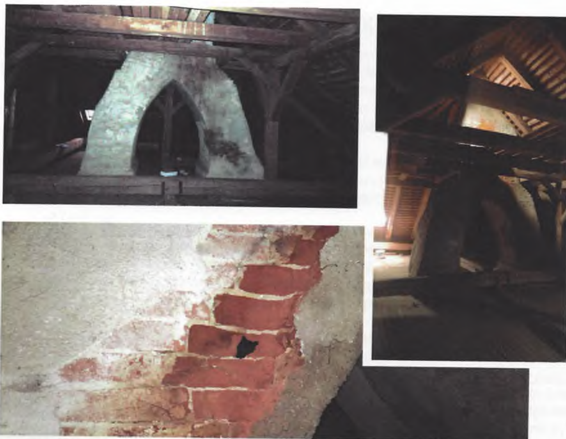
FOTO KOMÍNOVÉHO TĚLESA č.1 01/2018 stávající stav
