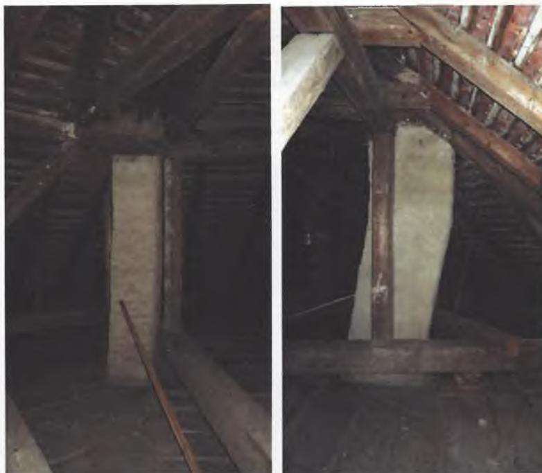
FOTO KOMÍNOVÉHO TĚLESA č.4 01/2018 Stávající stav
