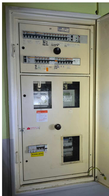
Obrázek 6.2 - Elektroměrový rozvaděč
