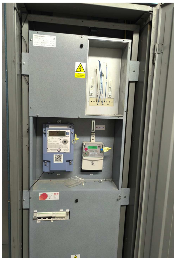
Obrázek 11.1 - Elektroměrový rozvaděč
