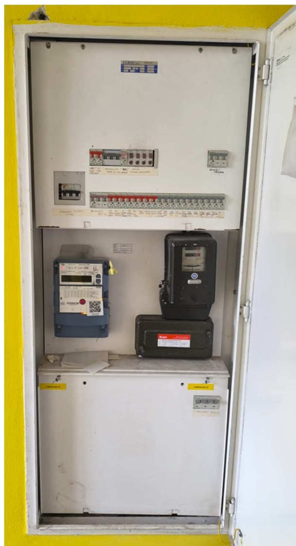
Obrázek 5.2 - Rozvaděč s elektroměrem pro společné prostory
