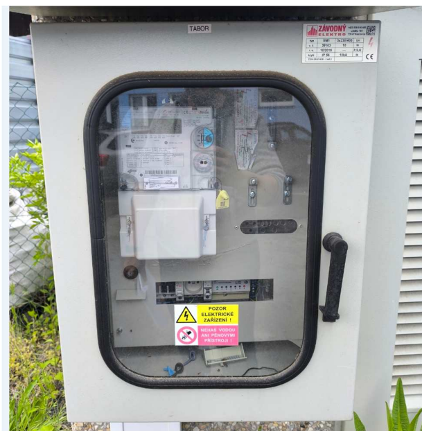
Obrázek 12.1 – elektroměrový rozvaděč
