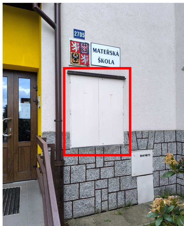
Obrázek 10.3 – venkovní strana rozvaděče, kterou bude nutno demontovat.
