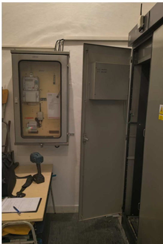
Obrázek 2.1 – situace hlavního rozvaděče a rozvaděče s elektroměry
