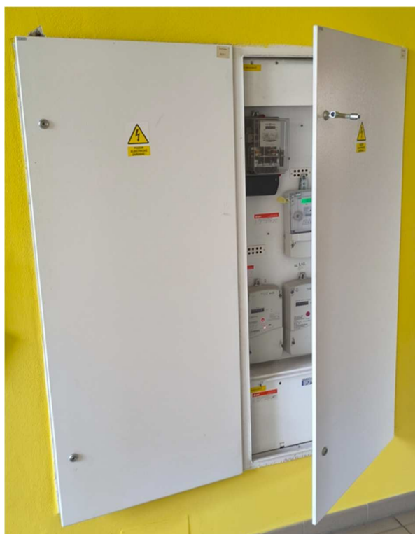
Obrázek 5.1 - Elektroměrový rozvaděč
