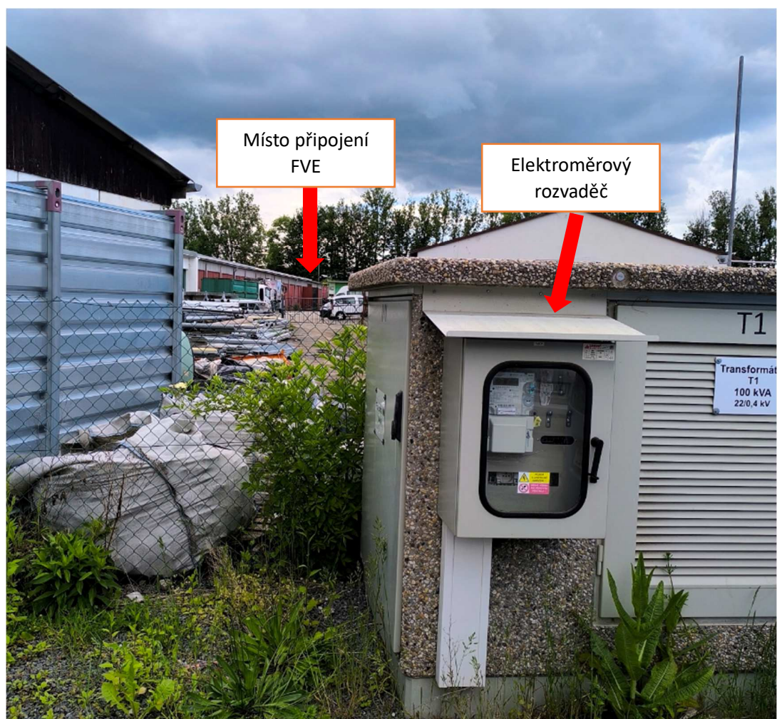
Obrázek 12.2 – umístění elektroměrového a místa připojení FVE
