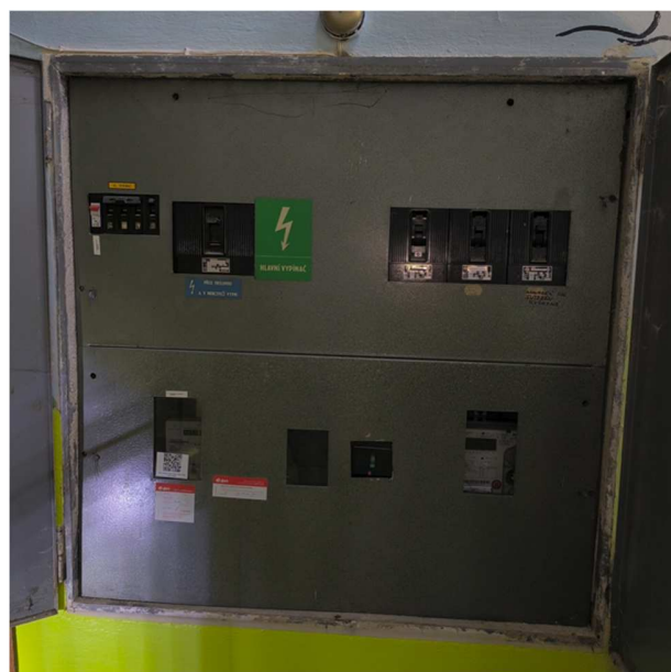
Obrázek 7.2 - Elektroměrový rozvaděč
