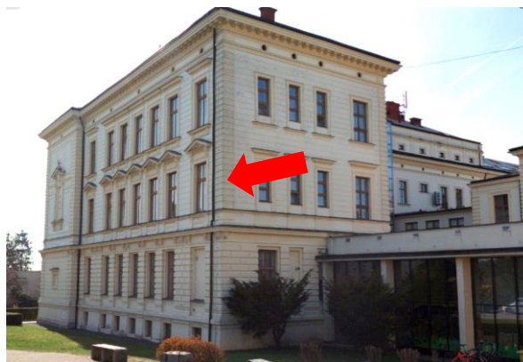
Obr. 28 – umístění kamery a pohled
