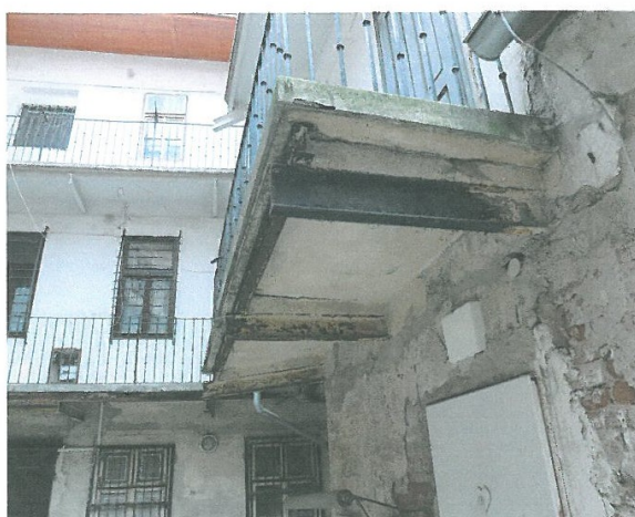
5 – Soustava podpor žb desek.
