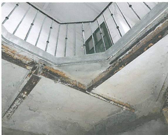
3 – Soustava podpor žb desek.
