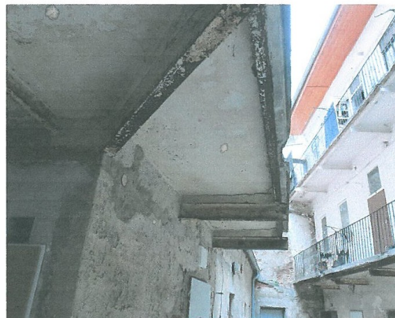
4 – Soustava podpor žb desek.
