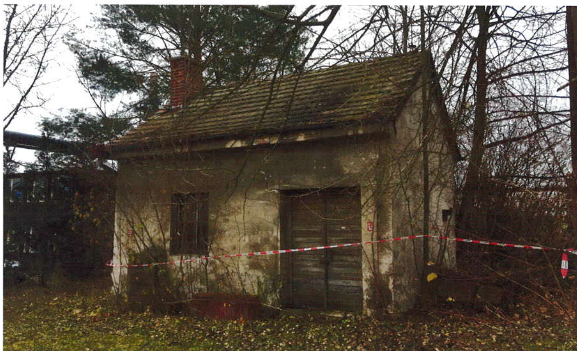
Obrázek č.1 Bouraný objekt - pohled
