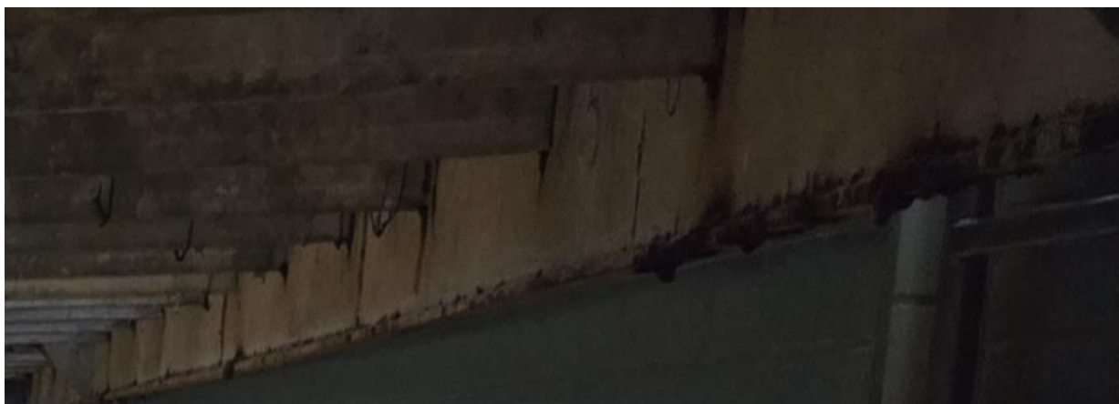
Obr. C-22 Detail spodní hrany nosné ocelové konstrukce mezidna v plaveckém bazénu.
