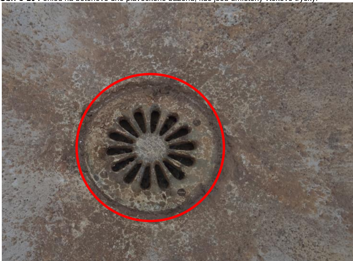
Obr. C-21 Detail vtokové trysky v betonovém dně plaveckého bazénu.
