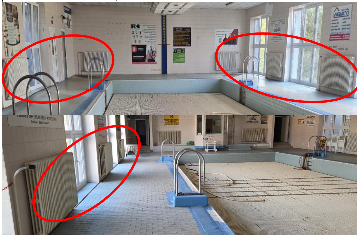
Obr. C-68 Pohled na stávající litinové radiátory v hale plaveckého krytého bazénu.
