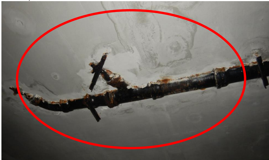
Obr. C-74 Pohled na ležatou kanalizaci z I.NP odvádějící vody z II.NP.
