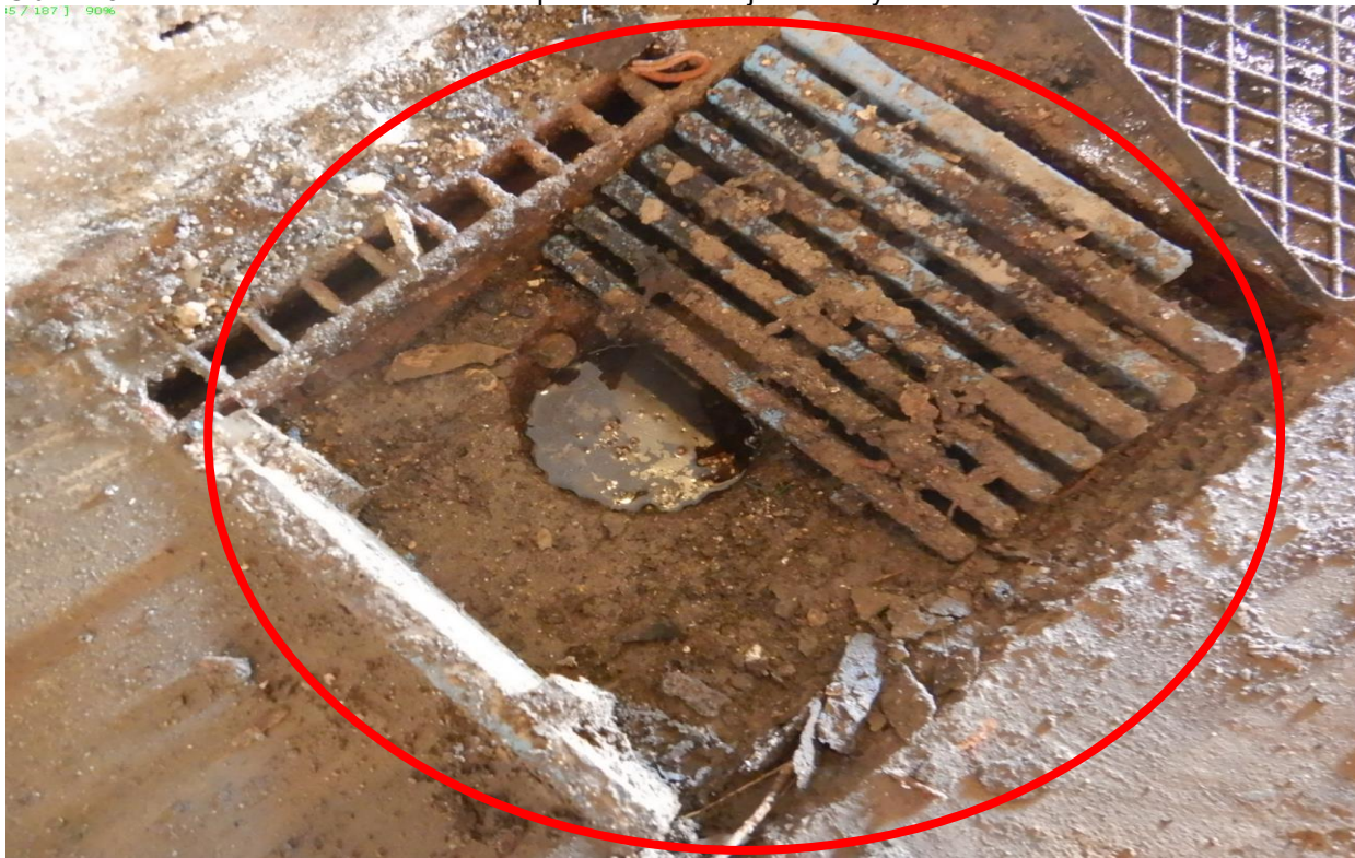
Obr. C-53 Pohled na odtokovou vpust' v podlaze chodeb kolem plaveckého bazénu v I.NP.
