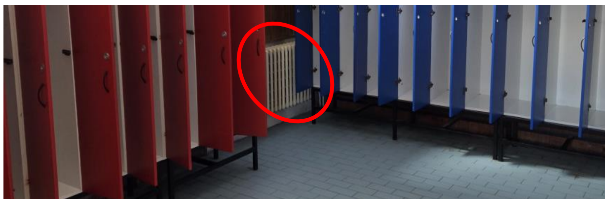
Obr. C-69 Pohled na stávající litinové radiátory v šatně plaveckého krytého bazénu.
