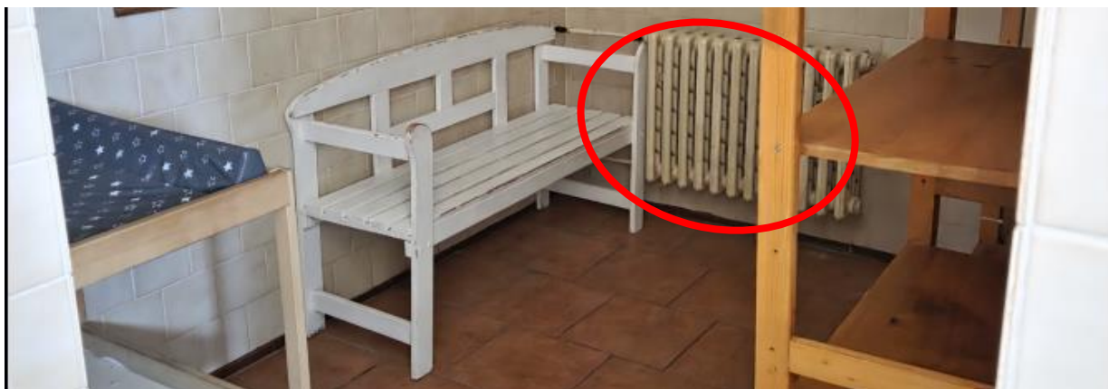
Obr. C-70 Pohled na stávající litinové radiátory v šatně plaveckého krytého bazénu.
