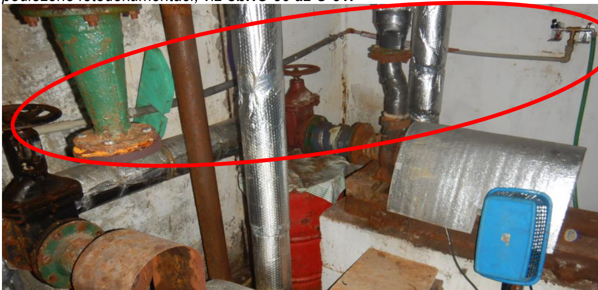
Obr. C-50 Pohled na rozvodné potrubí vodovodu v I.NP.
