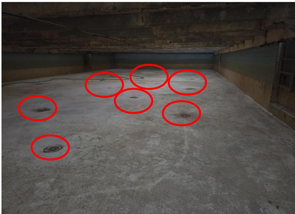
Obr. C-20 Pohled na betonové dno plaveckého bazénu, kde jsou umístěny vtokové trysky.
