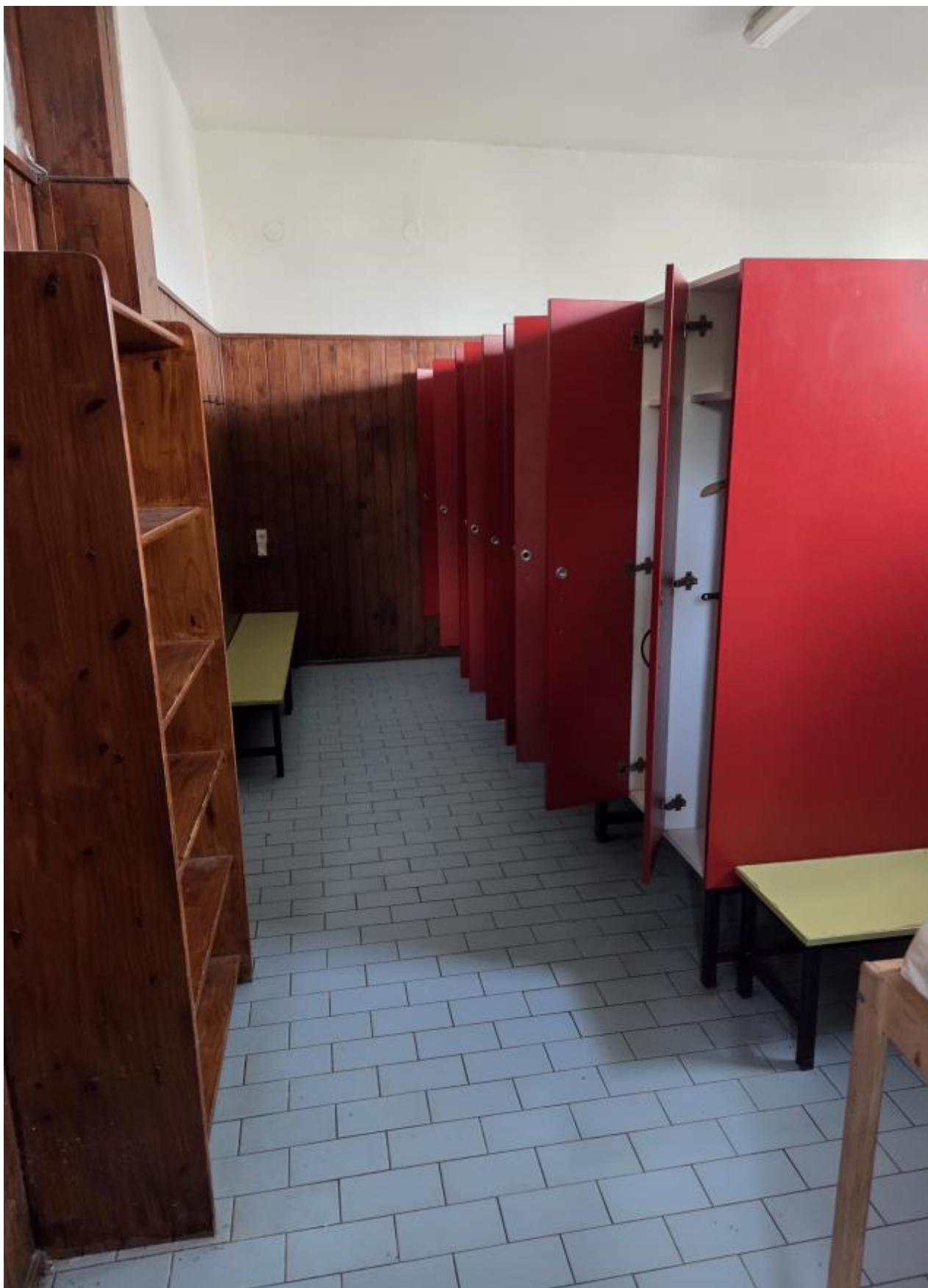
Obr. C-63 Pohled na stávající šatny v plaveckém krytém bazénu.
