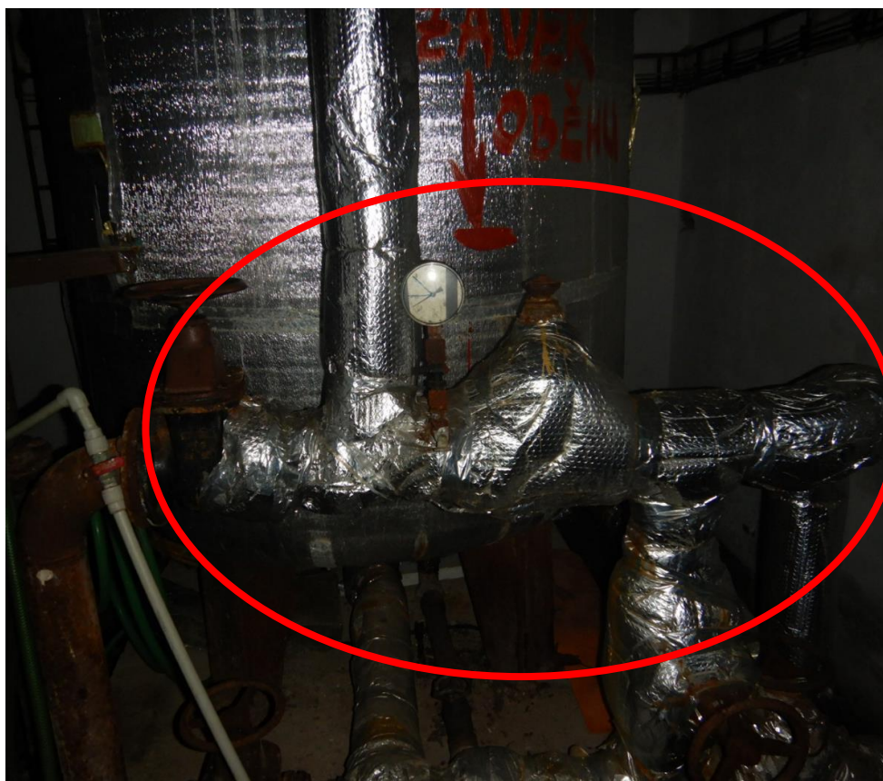
Obr. C-8 Pohled na ocelovou armaturní sestavu filtru plaveckého bazénu.
