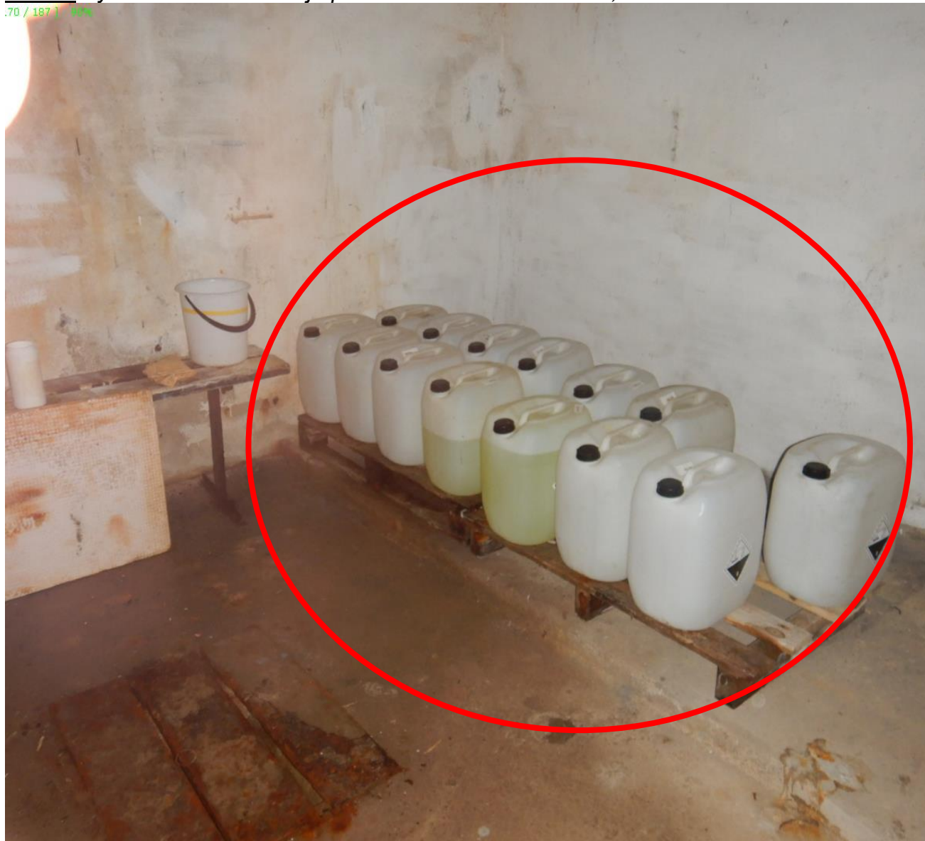
Obr. C-10 Pohled na způsob skladování jednotlivých činidel používaných následně k dávkování do vody plaveckého bazénu.
