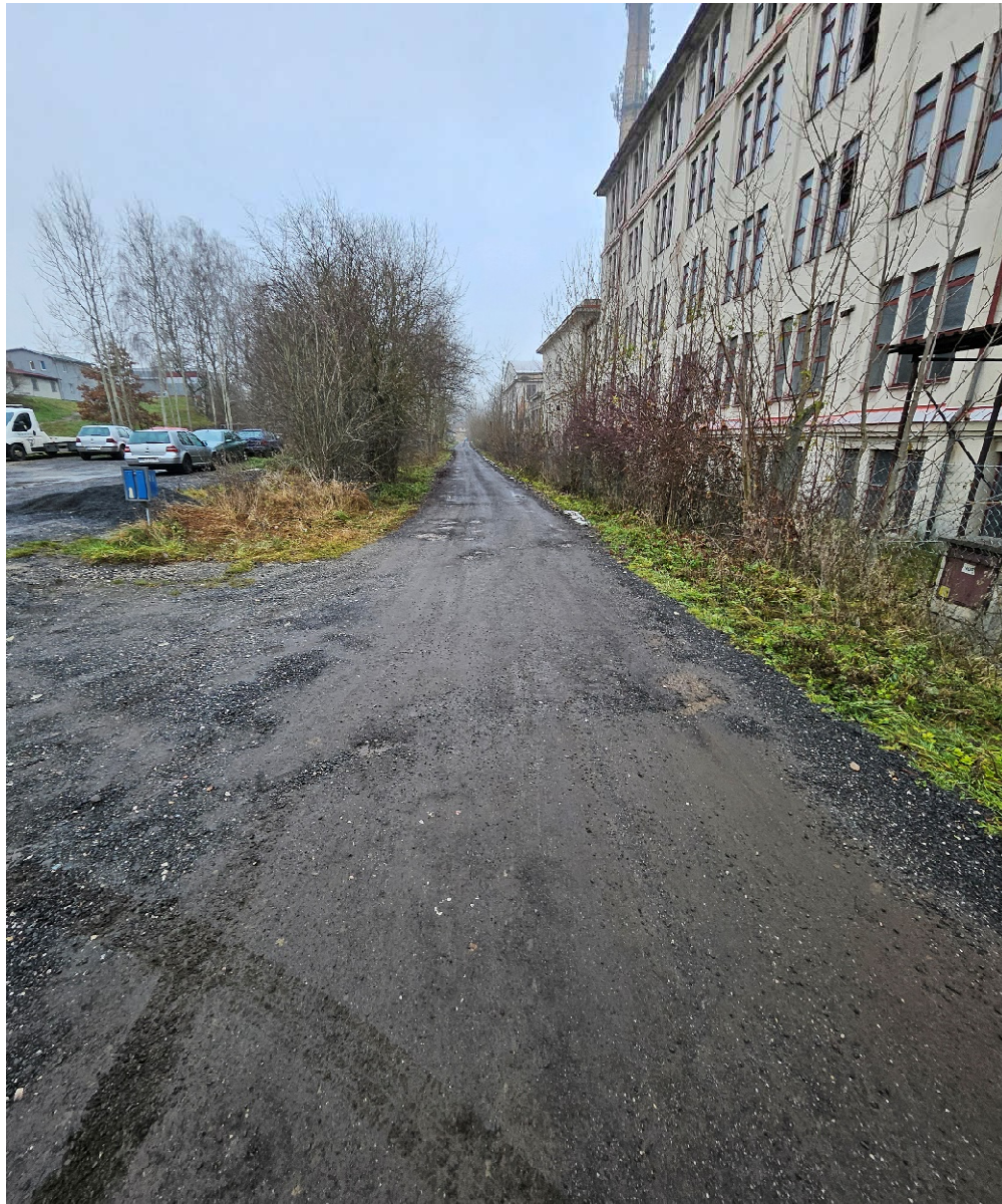
Foto současného stavu:
