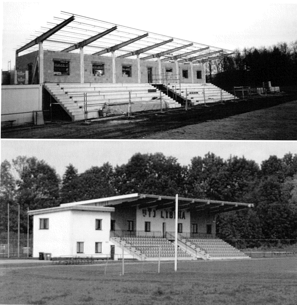
Obrázek 2: Podoba tribuny v průběhu rekonstrukce a po rekonstrukci
