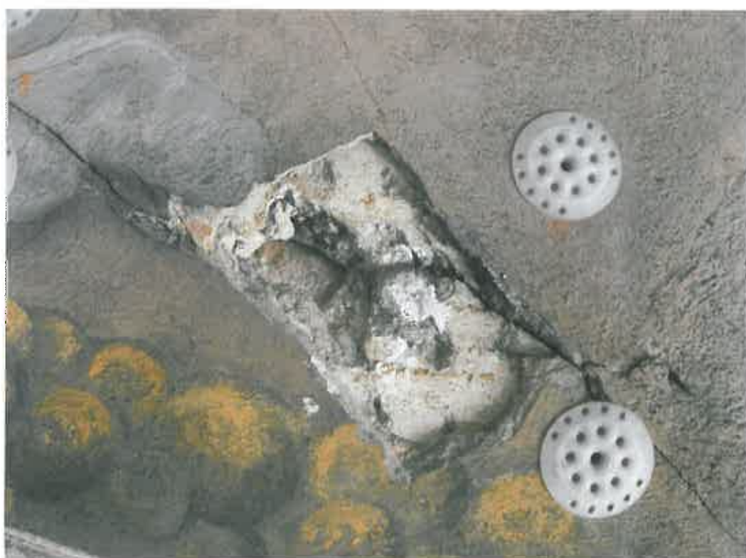
Sonda – na snímku vidíme dvě malířské úpravy – starší opekovaný, hlazený povrch uvolněný od zdiva na něm dvouvrstvá omítková vrstva s Etgensovou malbou
