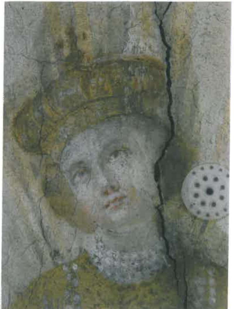
Malba uctívané sošky Panny Marie se statickou trhlinou podélně probíhající vrcholem klenby lodě se zajišťujícími kotvami
