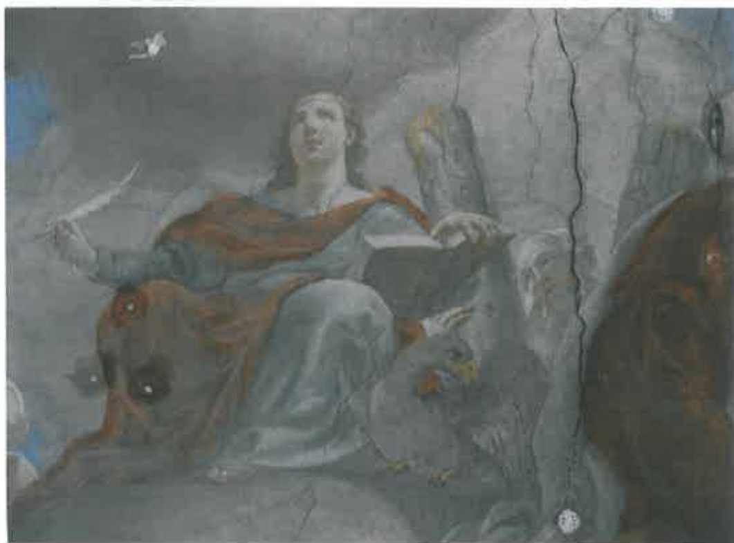
Detail – sv. Jan Evangelista – stav malby v průběhu injektáže
