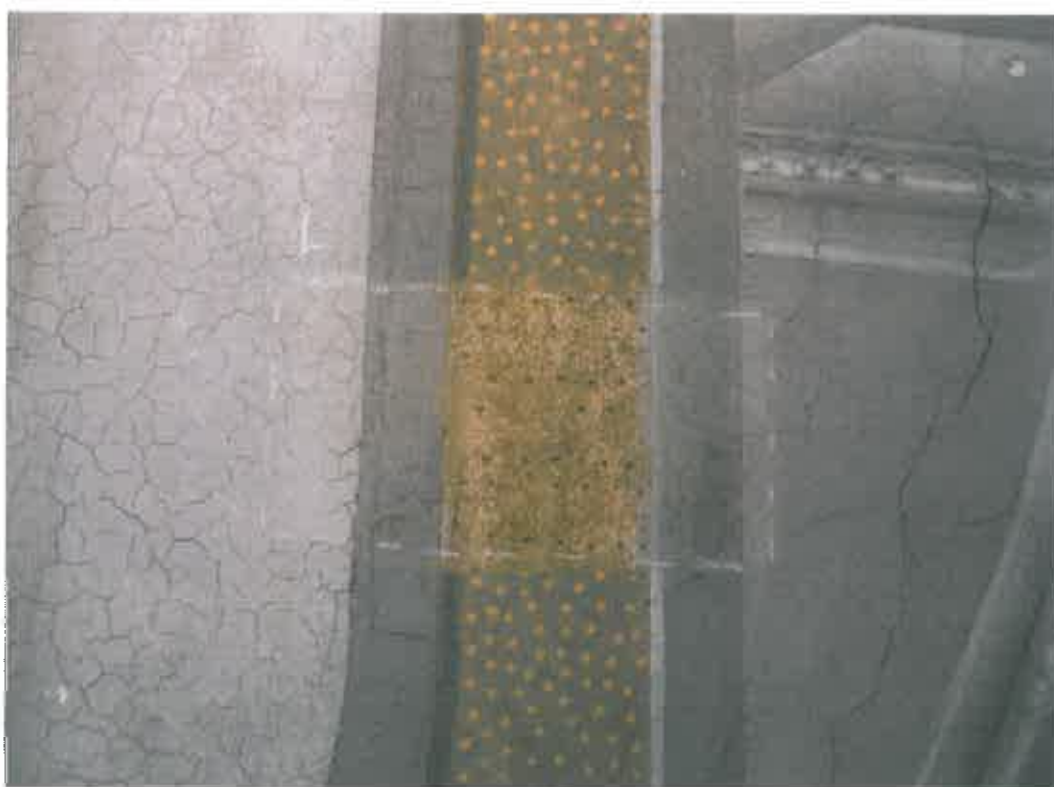
Sonda v ilusivní výplni prokázala původní zlacení detailů, které nebylo při opravách obnoveno, rytmizace bodů nebyla respektována
