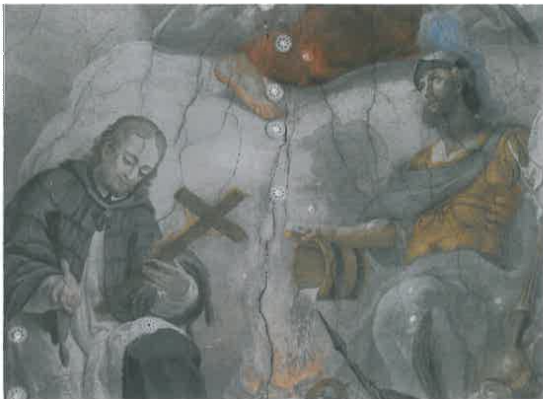
Část kompozice se sv. Janem Nepomuckým a sv. Floriánem v průběhu injektáže
