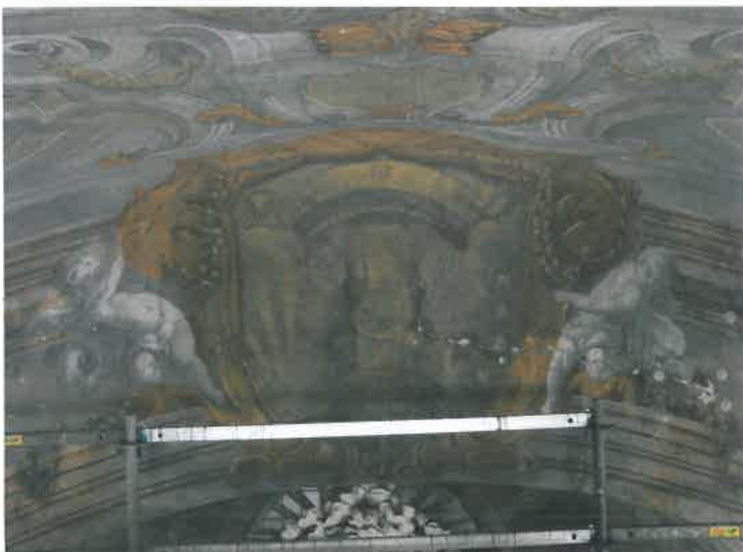
Stav Vítězného oblouku po injektáži – ponechány byly pouze terče, které fixují statické trhliny
