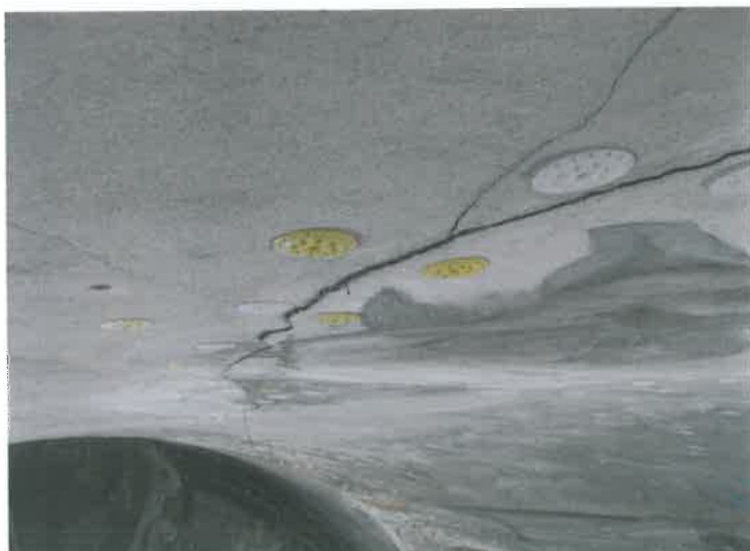
Malba andílků pod Pannou Marií zakrývá plošné poškození originálu a řadu vysprávek v omítce – malba je volnou rekonstrukcí silně poškozené barokní malby, dle charakteru pojednání pochází z cca 50-tých let 20.století
