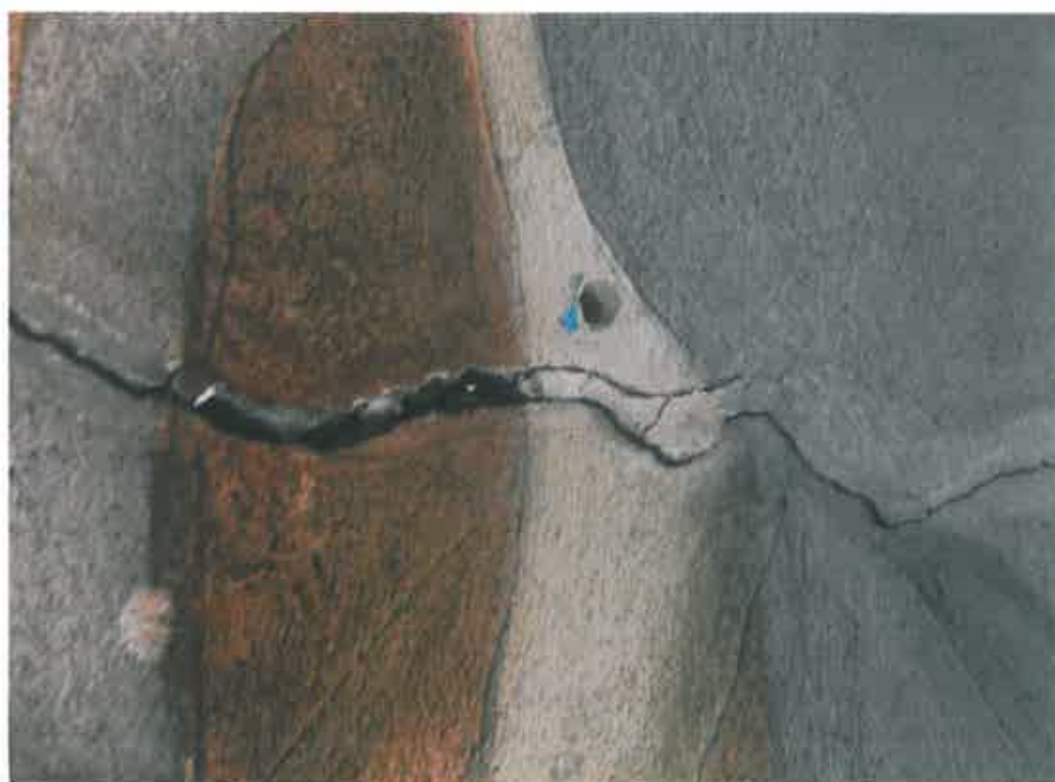
Detail – statická porucha s vypadávající starou, sádrovou výplní krytou retuší a přemalbou
