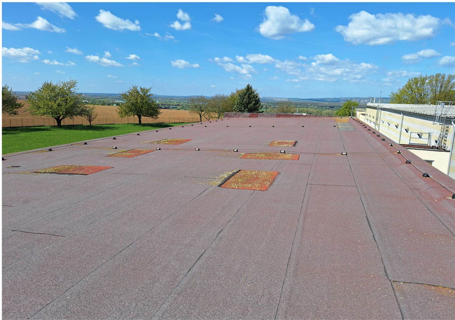
Střecha- pohled východní:
