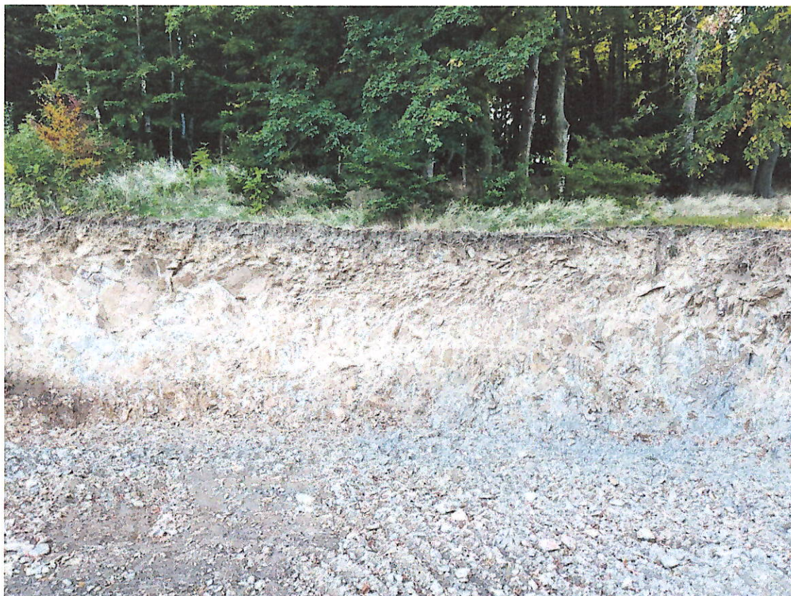
Obrázek 1 Fotodokumentace zadní stěny výkopu
