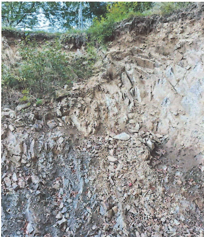
Obrázek 2 Fotodokumentace levé stěny výkopu
