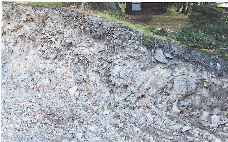
Obrázek 3 Fotodokumentace pravé stěny výkopu
