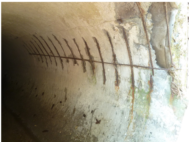
Podhled do konstrukce od výtoku
