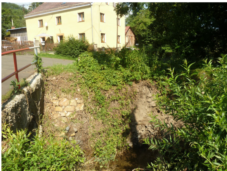
Podemletý svah vpravo za mostem
