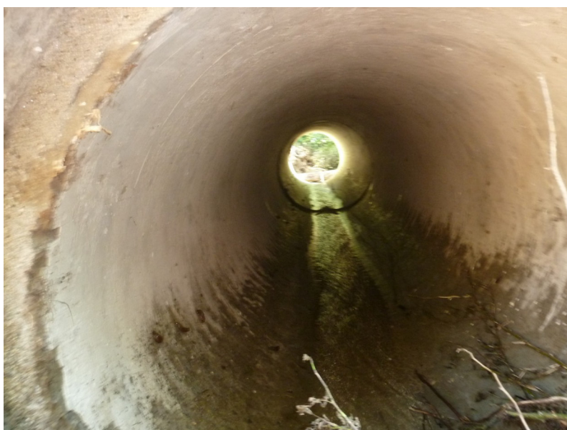
Podhled do konstrukce od vtoku
