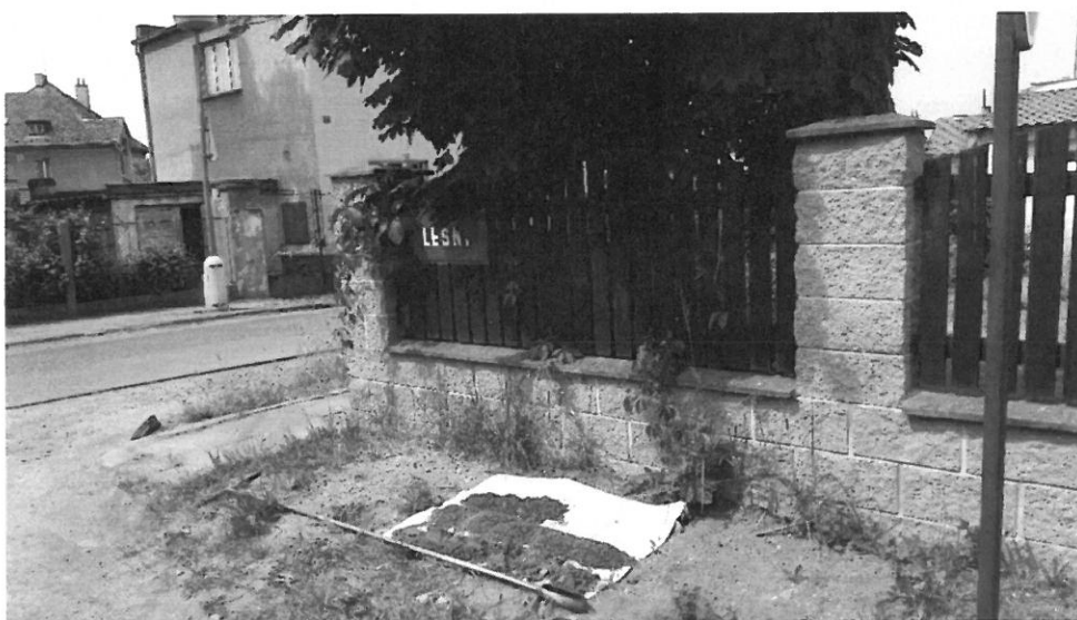
průzkumný vrt na rohu ulic Hlavní a Lesní
