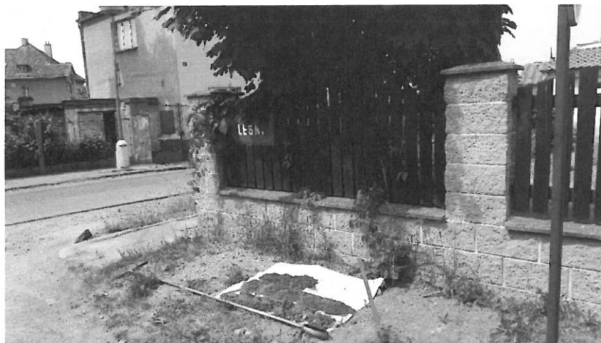
Obr. 1: Vrt NV1 pro zjištění geologické stavby a odběr vzorku písku
