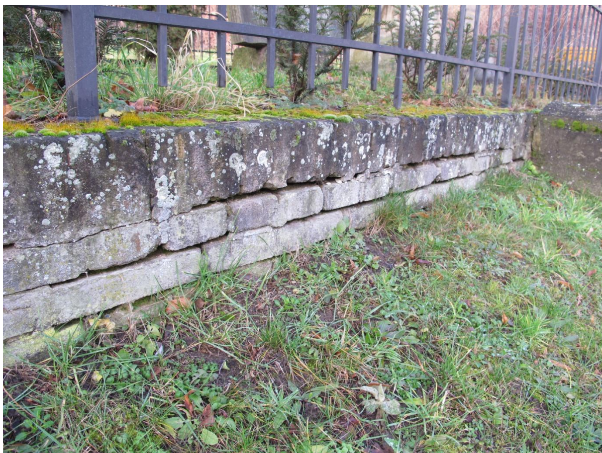
Dokumentace současného stavu cihlové podezdívky a vstupního schodiště
