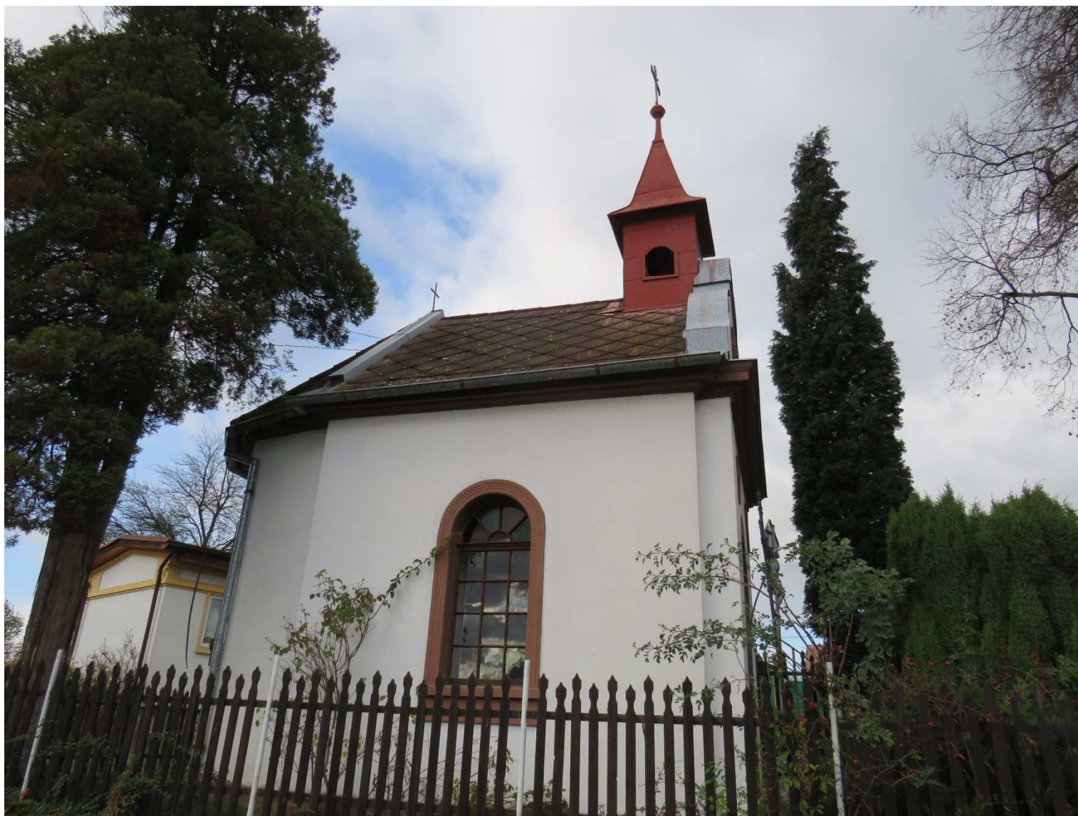
Pohled na kapli – jižní
