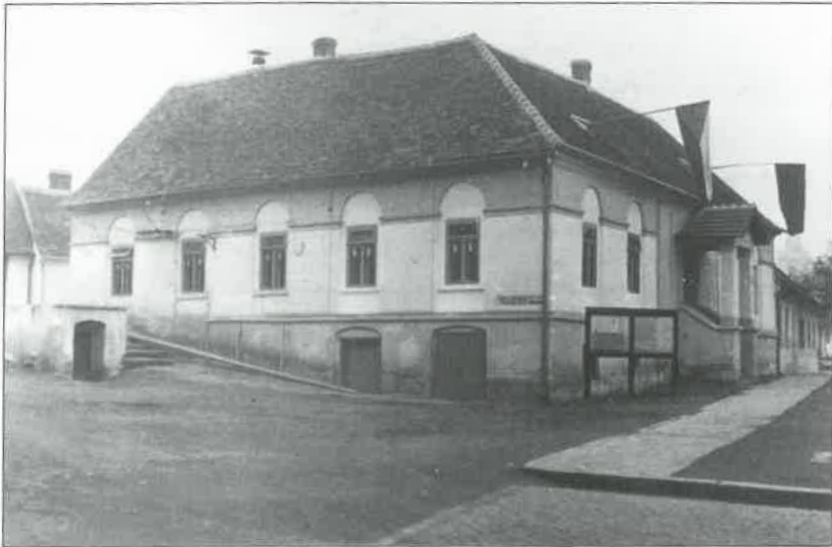
Od roku 1872 sídlila komínská škola v budově bývalého hostince, současně- kům známé jako „hasička“. Nacházel se tam také byt učitele. Snímek z 50. let 20. století
