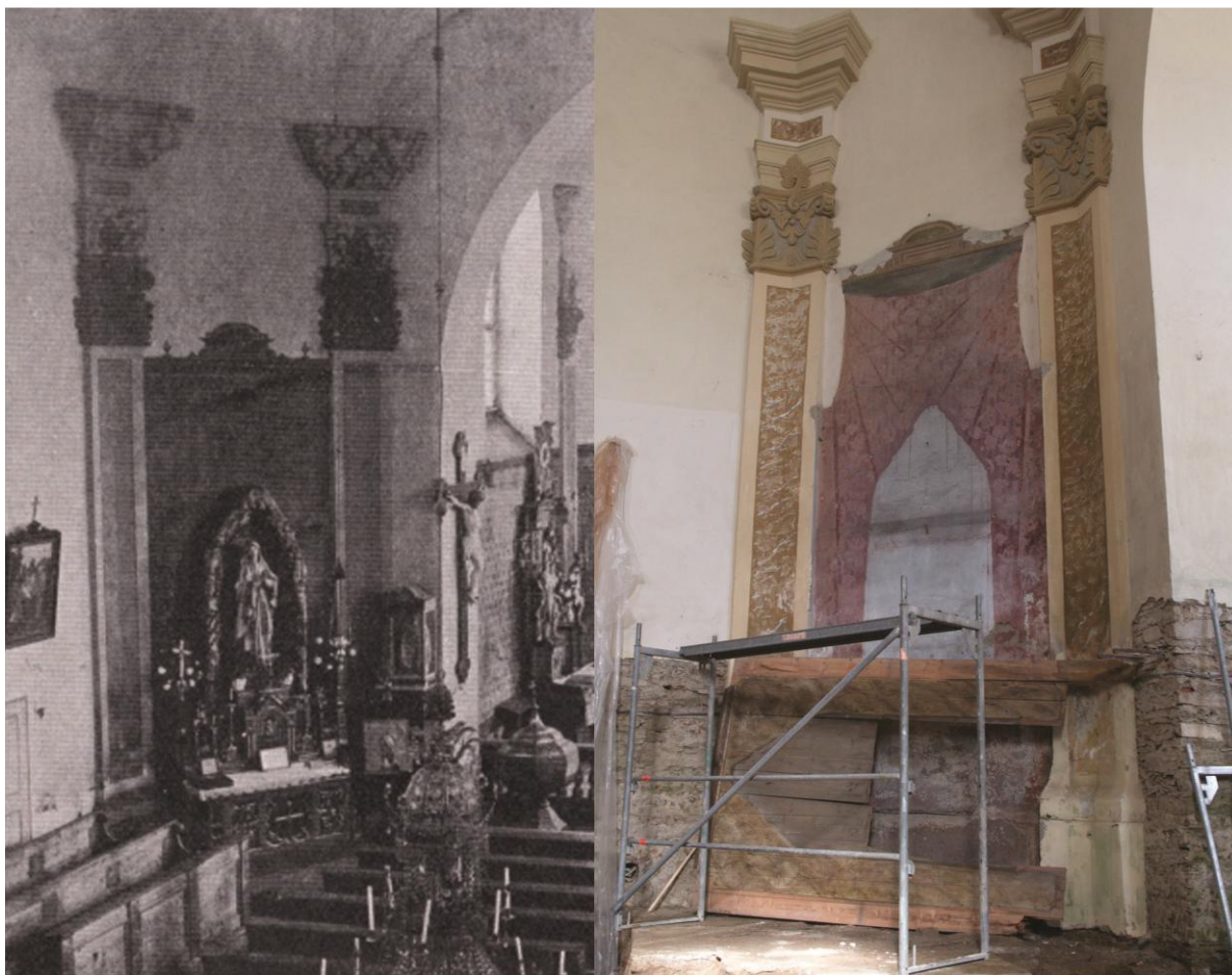
Oltář Panny Marie Lurdské – původní stav a stav po demontáži oltáře při stavební rekonstrukci interiéru kostela
