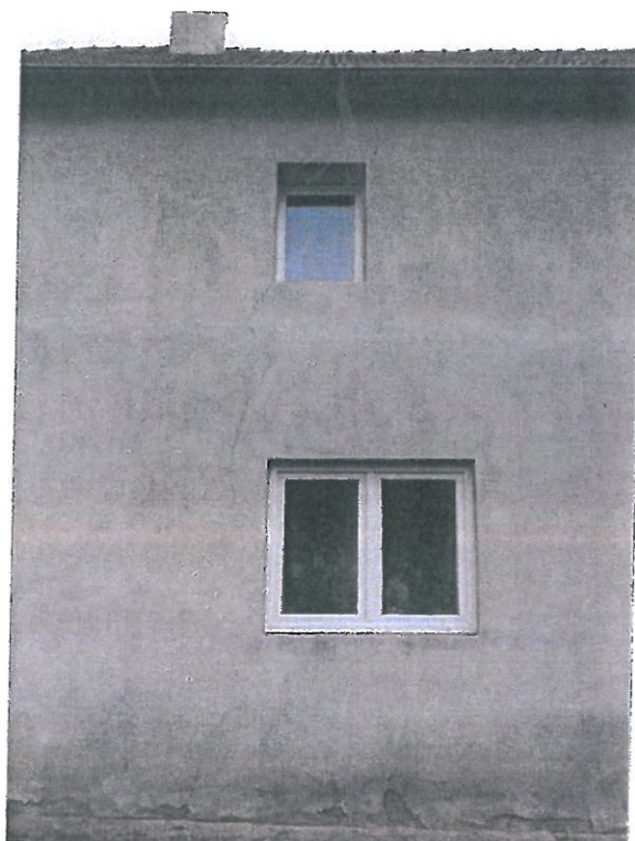
Foto 8 – pohled na fasádu směrem do uličky kudy povede trasa kanalizace
