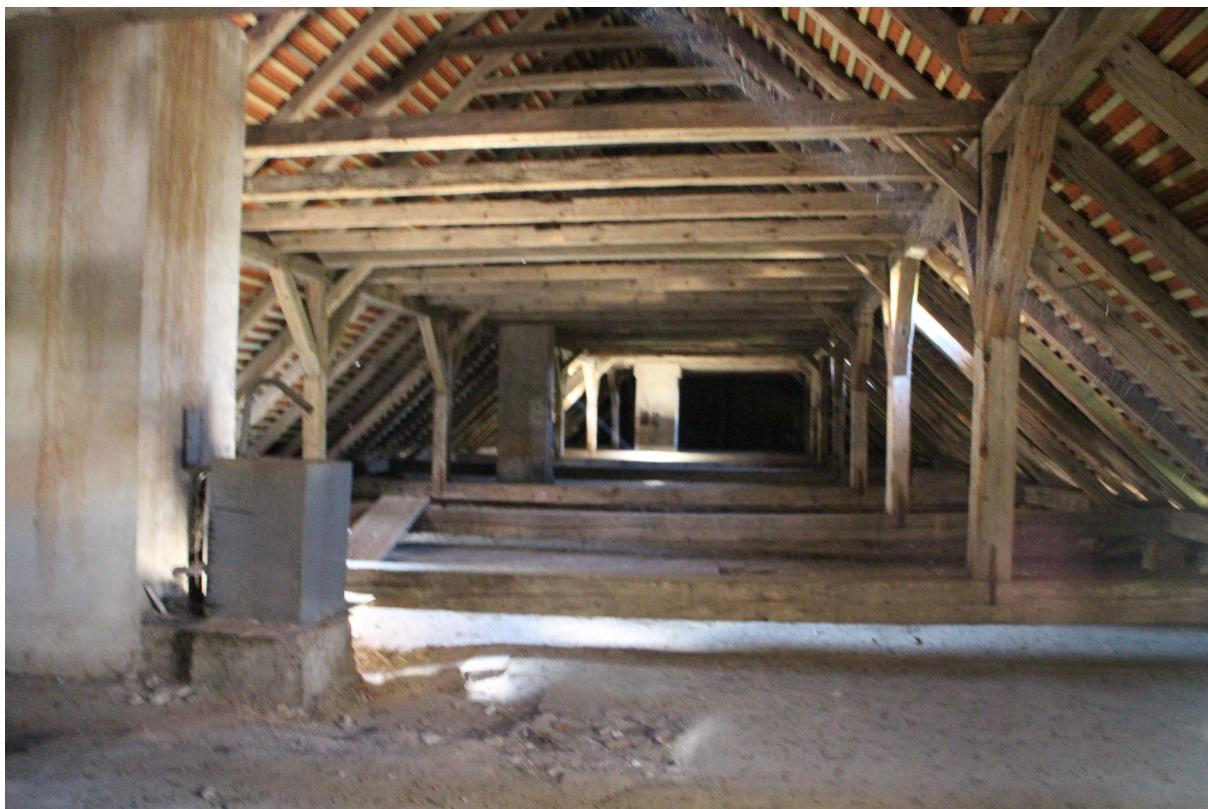
I.č. 03273-2017 Znojmo, někdejší klášter v Louce. Západní křídlo středověké kvadratury - Stará škola. Prostor krovu - pohled od severu.
