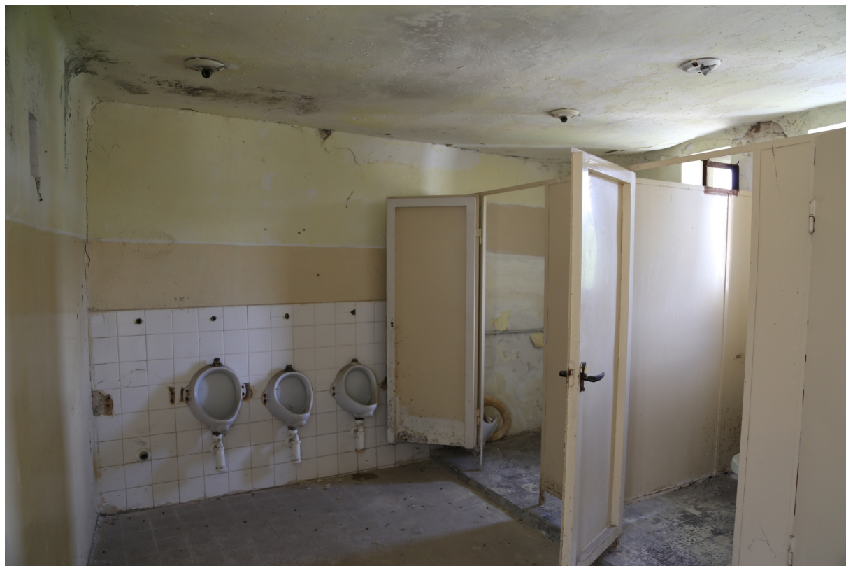
I.č. 03459-2017 Znojmo, někdejší klášter v Louce. Západní křídlo středověké kvadratury - Stará škola. Patro, chlapecké záchodky 2.13 - pohled od severu.
