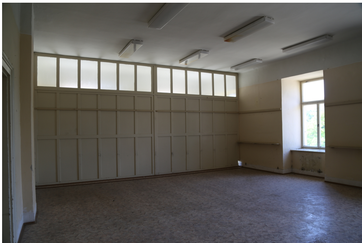
I.č. 03450-2017 Znojmo, někdejší klášter v Louce. Západní křídlo středověké kvadratury - Stará škola. Patro, místnost 2.09 - pohled na jižní dřevěnou stěnu.
