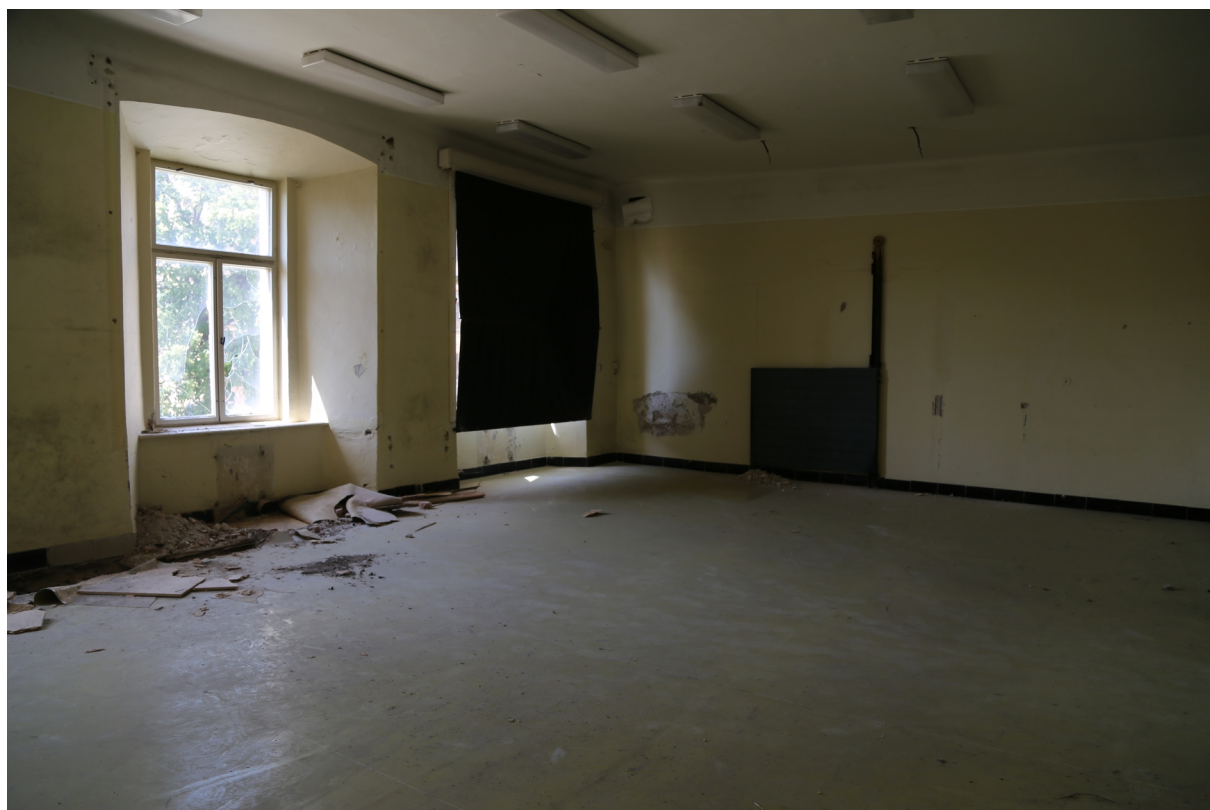
I.č. 03684-2017 Znojmo, někdejší klášter v Louce. Západní křídlo středověké kvadratury - Stará škola. Patro, místnost 2.08 - pohled do severozápadního kouta. Na snímku je statická sonda při průčelí a sonda pod omítky v severní stěně.
