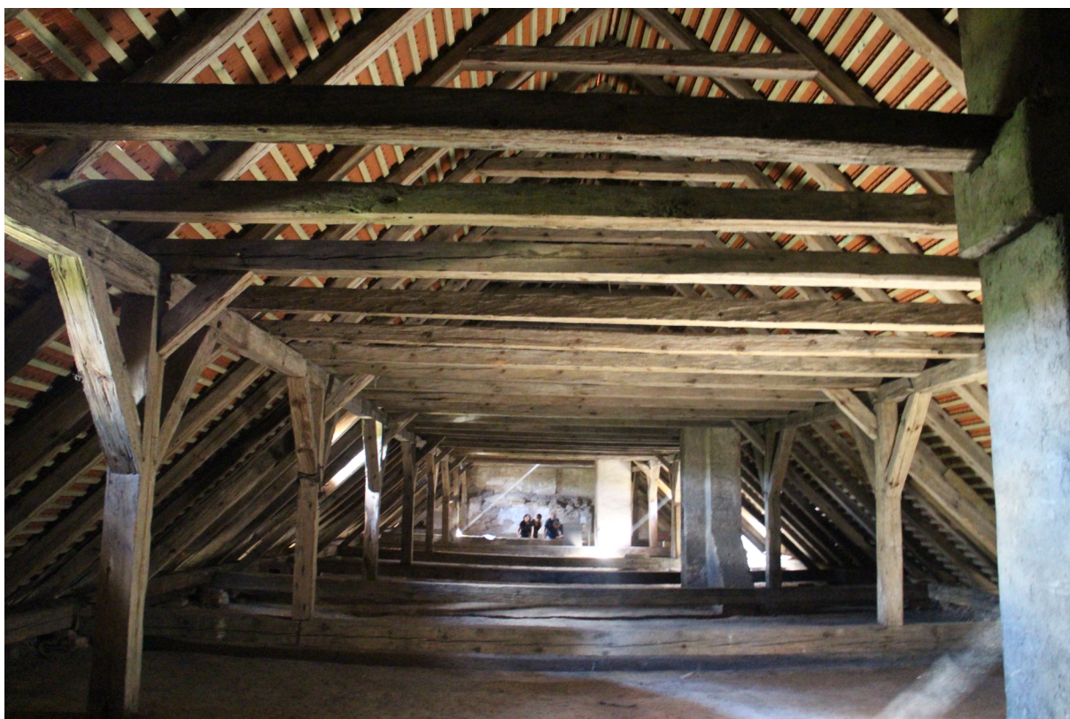
I.č. 03334-2017 Znojmo, někdejší klášter v Louce. Západní křídlo středověké kvadratury - Stará škola. Prostor krovu - pohled od jihu.
