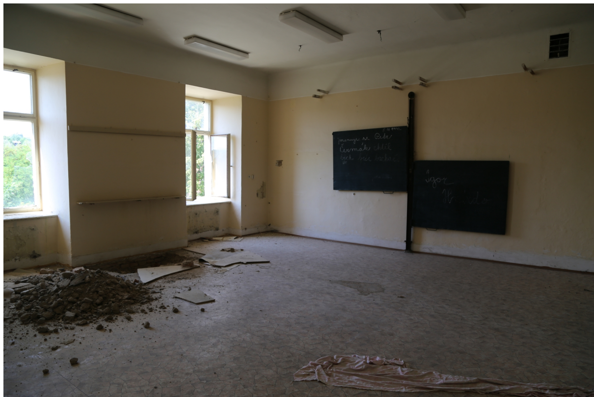
I.č. 03687-2017 Znojmo, někdejší klášter v Louce. Západní křídlo středověké kvadratury - Stará škola. Patro, místnost 2.09 - pohled do severozápadního kouta.
