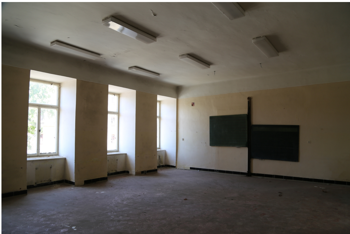
I.č. 03513-2017 Znojmo, někdejší klášter v Louce. Západní křídlo středověké kvadratury - Stará škola. Patro, místnost 2.04 - pohled do severozápadního kouta.
