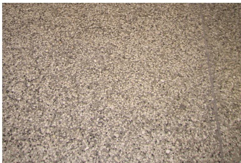
↑ Stávající barevnost teracových schodů a podlahy v předsálí
