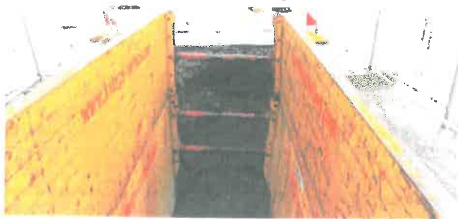
Obr. 1 Snímek z provádění startovací jámy.
