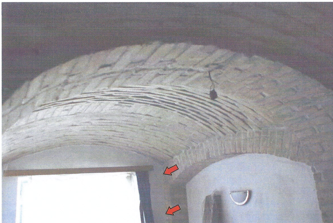
Foto č.5..... Klenby přízemí
