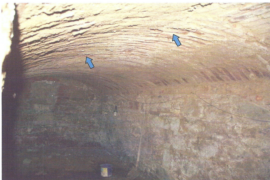
Foto č.4.....Sklepní prostory
