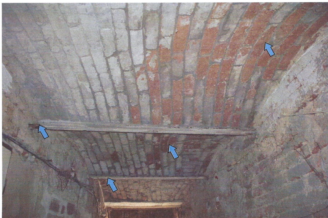
Foto č.6..... Klenby do ocelových nosníků v přízemí
