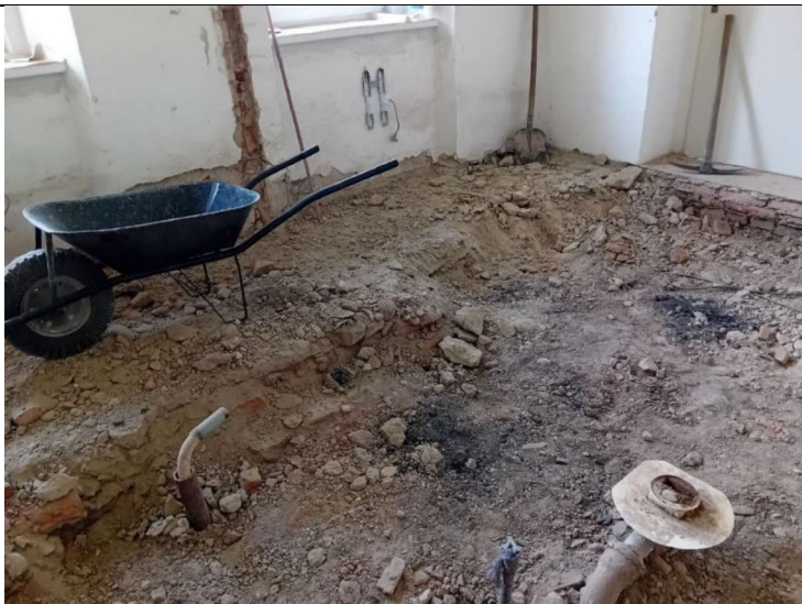
Konstrukce podlahy po odstranění poškozené mazaniny
