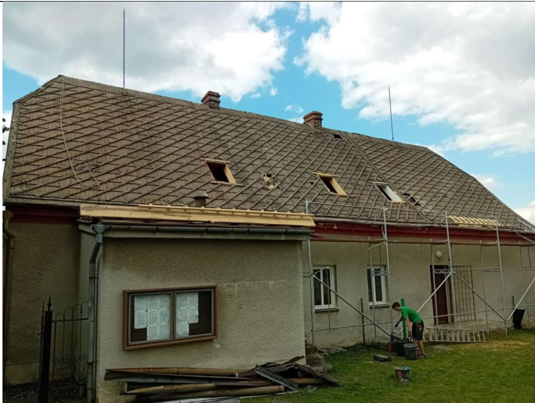
Pohled na střechu – severní strana.
