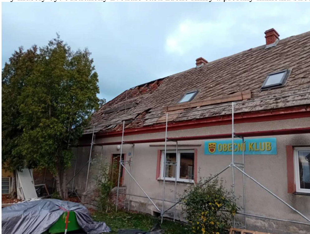
Pohled na klubovnu z ulice – krytina demontována
