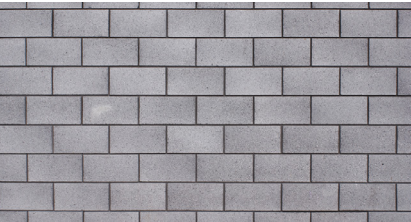
BETONOVÉ TVÁRNICE POHLEDOVÉ, VIDITELNÉ ROZVODY 3
