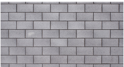
BETONOVÉ TVÁRNICE POHLEDOVÉ, VIDITELNÉ ROZVODY 3
