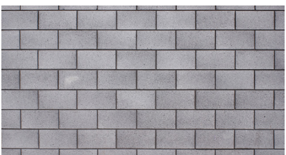
BETONOVÉ TVÁRNICE POHLEDOVÉ, VIDITELNÉ ROZVODY 3
