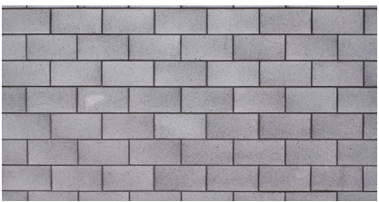
BETONOVÉ TVÁRNICE POHLEDOVÉ, VIDITELNÉ ROZVODY 3
