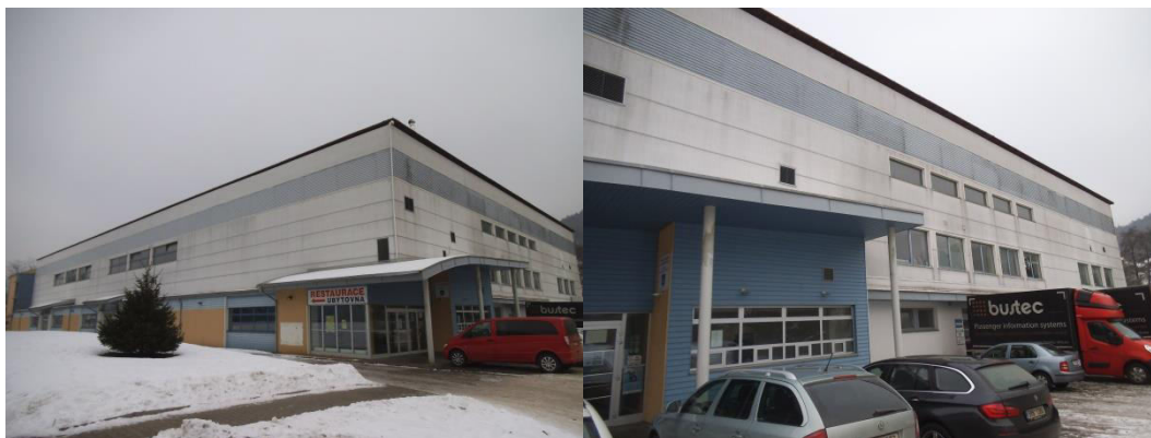
foto č. 1 a 2 – hala zimního stadionu
