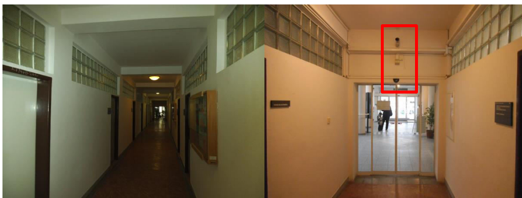
foto č. 13 a 14 – vnitřní prostory Městského úřadu (společné chodby); vpravo chodba pokryta kamerou a čidlem EZS
