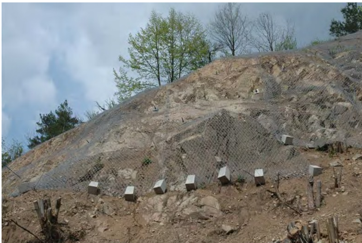
Obr. 12. Detailní pohled na výstavbu stabilizačních opatření za domem Myslínova č. p. 47. Horní část záchytné sítě a hřebíky, kotvící větší bloky proti odpadnutí. Foto O. Krejčí 2008.
